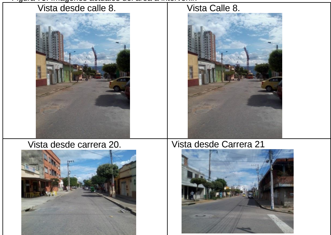
Figura 75. Imágenes actuales del área a intervenir.
