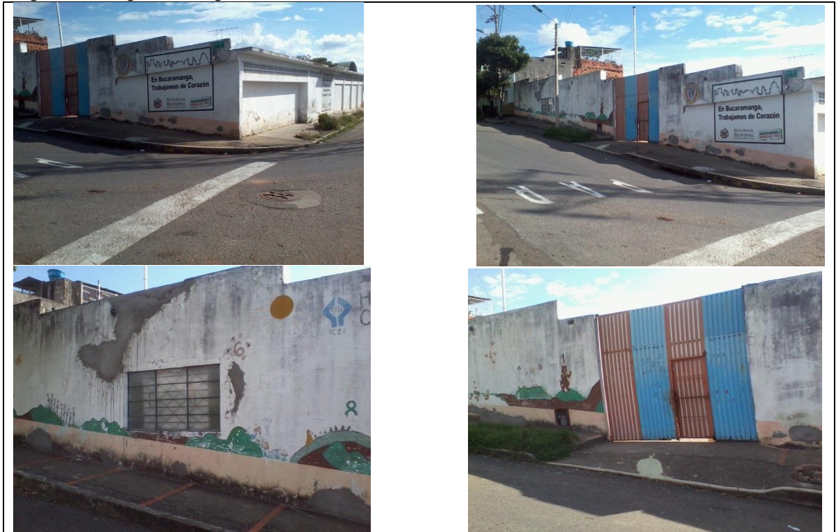
Figura 26. Registro Fotográfico De Infraestructura Administrada Por El I.C.B.F.
