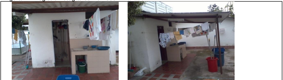
Figura 21. Registro Fotográfico De Aseo Y Lavado.
