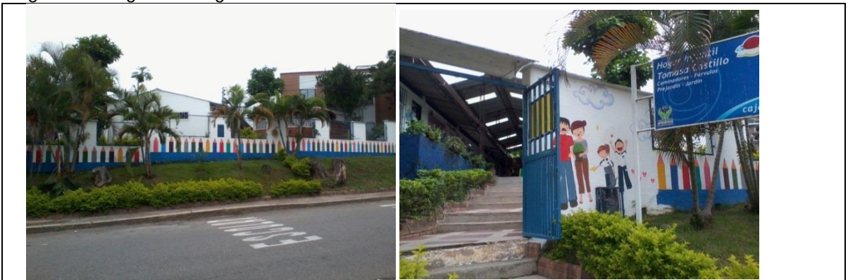
Figura 25. Registro Fotográfico De Fachada.
