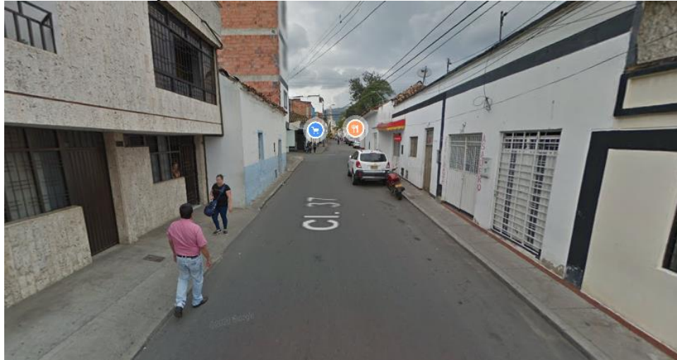
Figura 53. Estado de la vía y andenes de la calle 37
