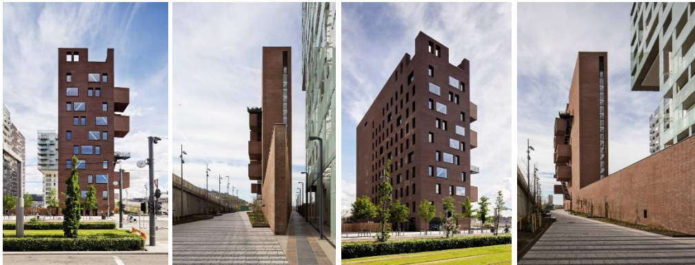
Figura 14. Edificio The Wedga . Composición formal y volumétrica
