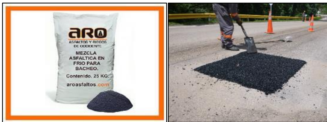
Ilustración 10: Mezcla asfáltica en frío
