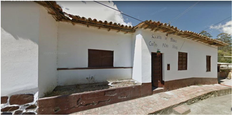
Figura 20. Fachada de la Escuela de Música – Casa de la Cultura.
