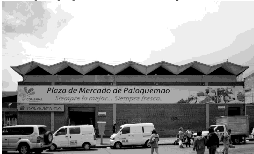
Figura 27. Fachada acceso principal plaza de mercado de Paloquemao
