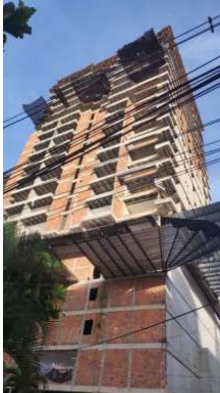
Figura 7. Avance de actividades en mampostería del proyecto Palace Condominio de la empresa INNOVA S.A.S
