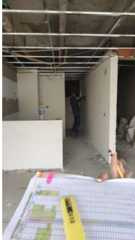
Figura 4. Avance de actividades en drywall del proyecto Palace Condominio de la empresa INNOVA S.A.S
