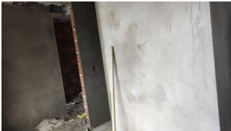
Figura 11. Avance de actividades de friso del proyecto Palace Condominio de la empresa INNOVA S.A.S
