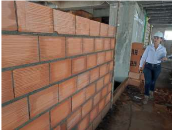
Figura 8. Avance de actividades en mampostería del proyecto Palace Condominio de la empresa INNOVA S.A.S
