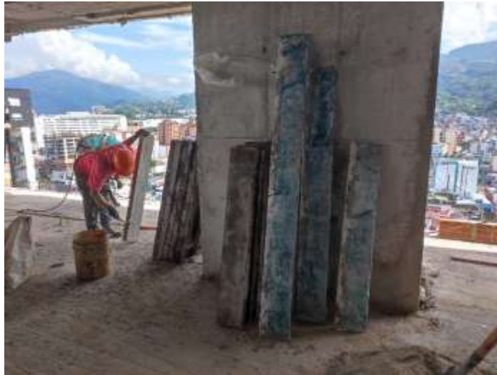
Figura 10. Avance de actividades fomaletéo del proyecto Palace Condominio de la empresa INNOVA S.A.S
