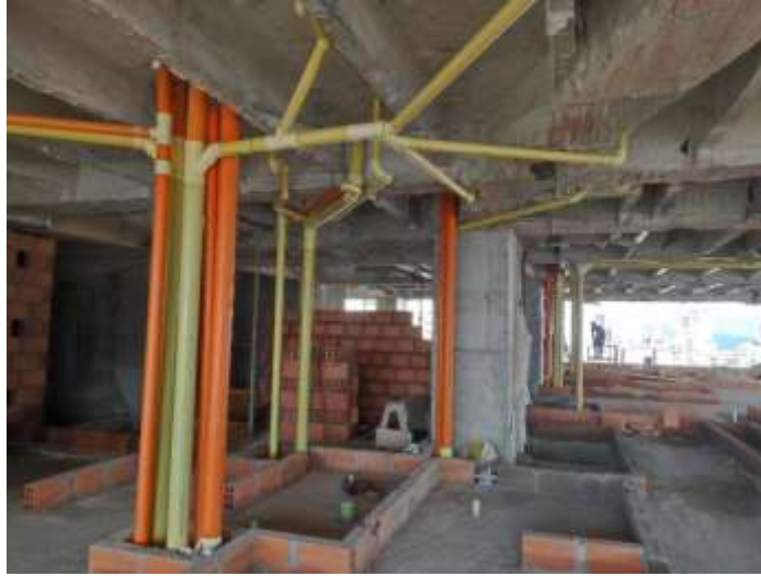
Figura 9. Avance de actividades en redes hidrosanitarias del proyecto Palace Condominio de la empresa INNOVA S.A.S
