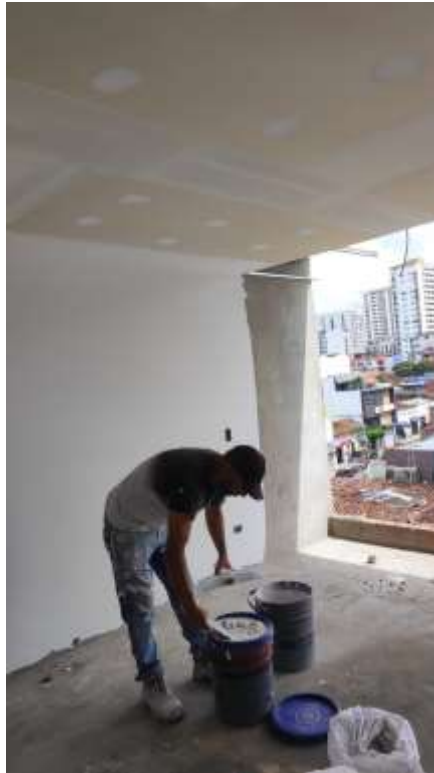
Figura 5. Avance de actividades en pintura del proyecto Palace Condominio de la empresa INNOVA S.A.S
