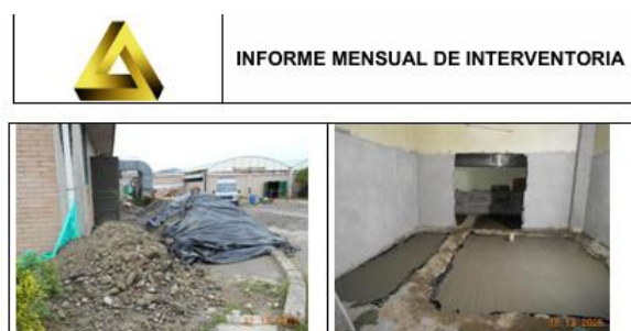
Figura 6. Actividades ejecutadas en los diferentes frentes de trabajo
