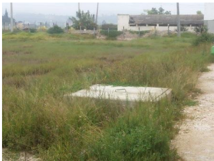
Imagen 11: Se muestra un pozo de inspección en la parte posterior del establecimiento de piscinas. Fuente Autores 2017.
