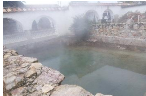
Imagen 8: Se muestra pozo 2 de captación de agua termal. Este sitio genera gran cantidad de agua, con poco material suspendido. Fuente Autores 2017.
