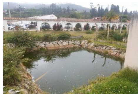
Imagen 10: Muestra pozo 3 rectangular de captación en total abandono, pues sus aguas muestran olor y color no aceptable. Fuente Autores 2017.
