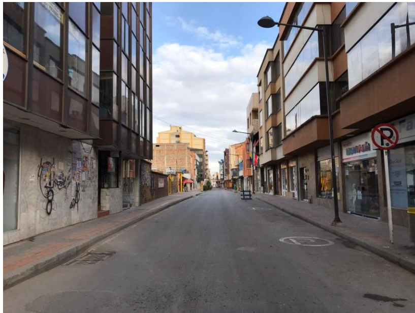
Figura 58. Estado actual Calle 14
