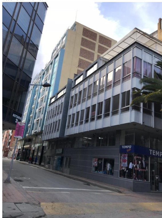
Figura 55. Fachadas vecinas carrera 14
