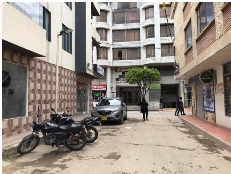
Figura 61. Estado actual Calle 14 A
