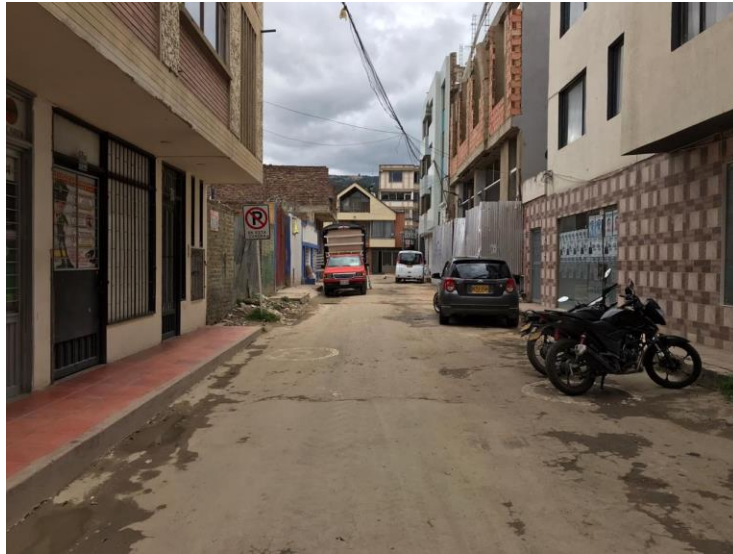
Figura 60. Estado actual Calle 14 A
