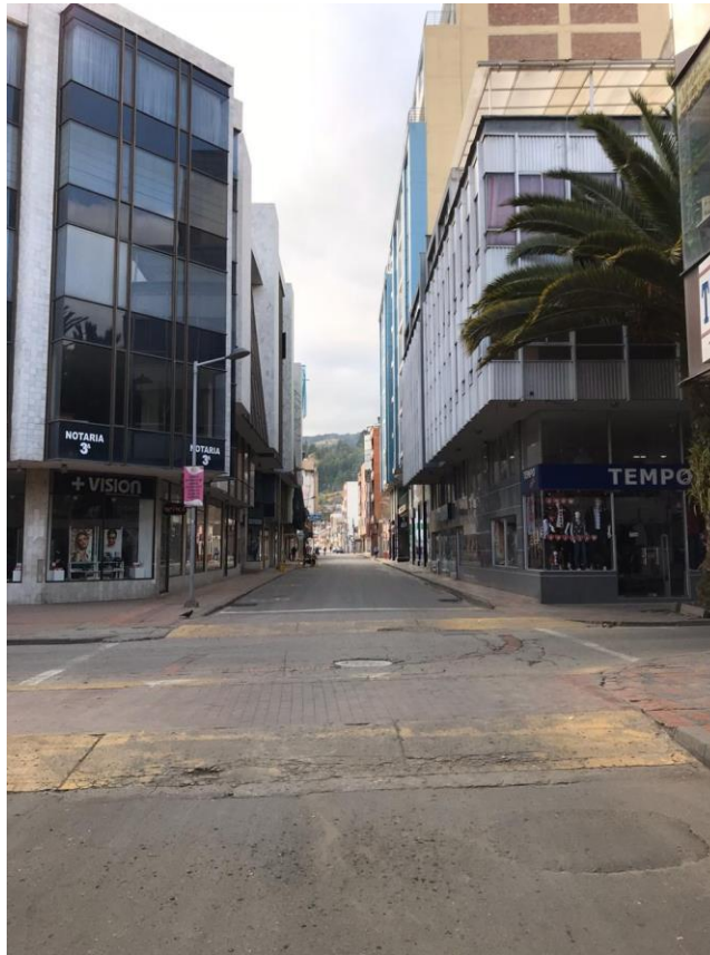
Figura 59. Estado actual Calle 14
