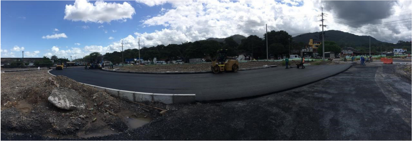
FIGURA 80. Construcción de pavimento flexible/rígido
