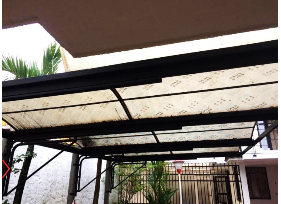
FIGURA 24. Cubierta soportada con vigas metálicas
