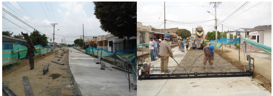
FIGURA 81. Construcción de pavimento rígido
