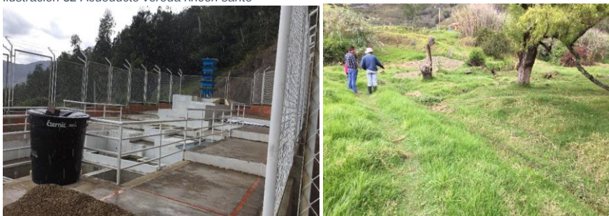
Ilustración 32 Acueducto vereda rincón santo
