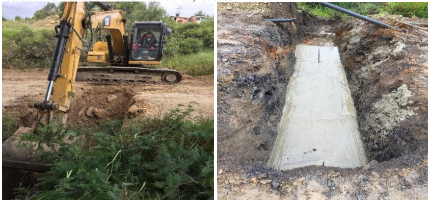
Ilustración 26 Excavación Alcantarillas Nuevas y Solados
