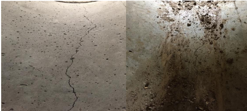
Ilustración 28 Fisura tubería 36"
