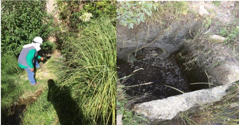
Ilustración 19 Verificación Alcantarillas actuales
