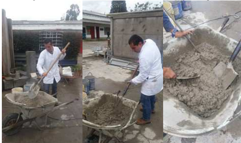
Figura 19. Elaboración de Mezclas de Concreto para Vigas.
