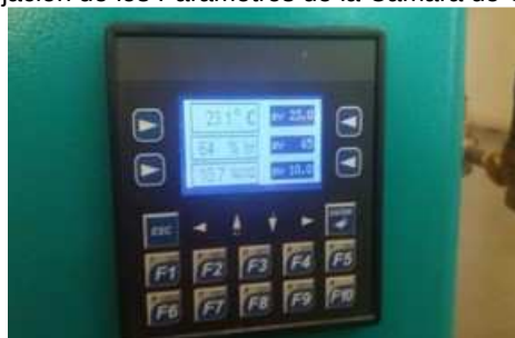
Figura 16. Fijación de los Parámetros de la Cámara de Carbonatación.
