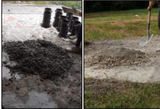
Figura 9.3 Preparación de la mezcla Fuente: Autores
