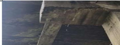
Fotografía N°6 viga vista bajo placa
