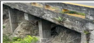
Fotografía N°2 vista lateral del puente
