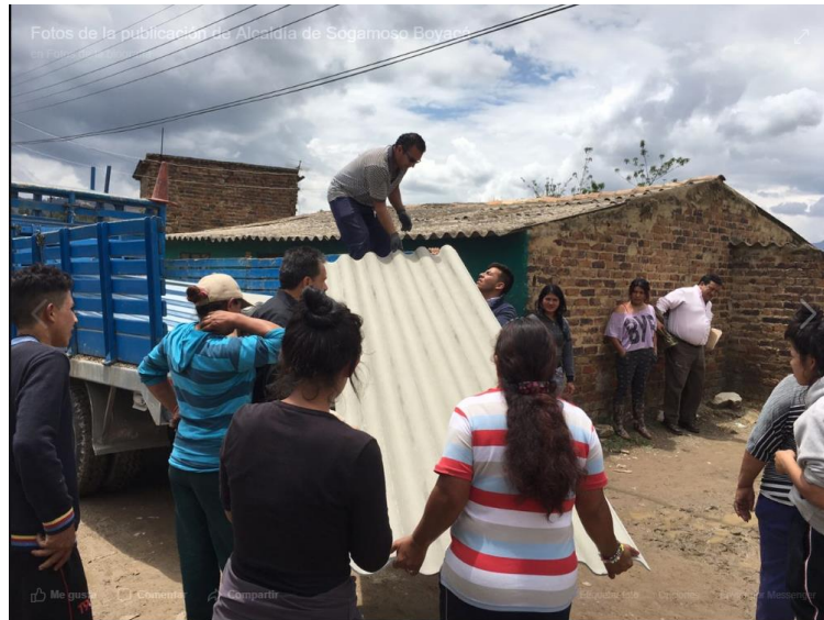
Figura 29. Entrega de materiales para mejoramiento
