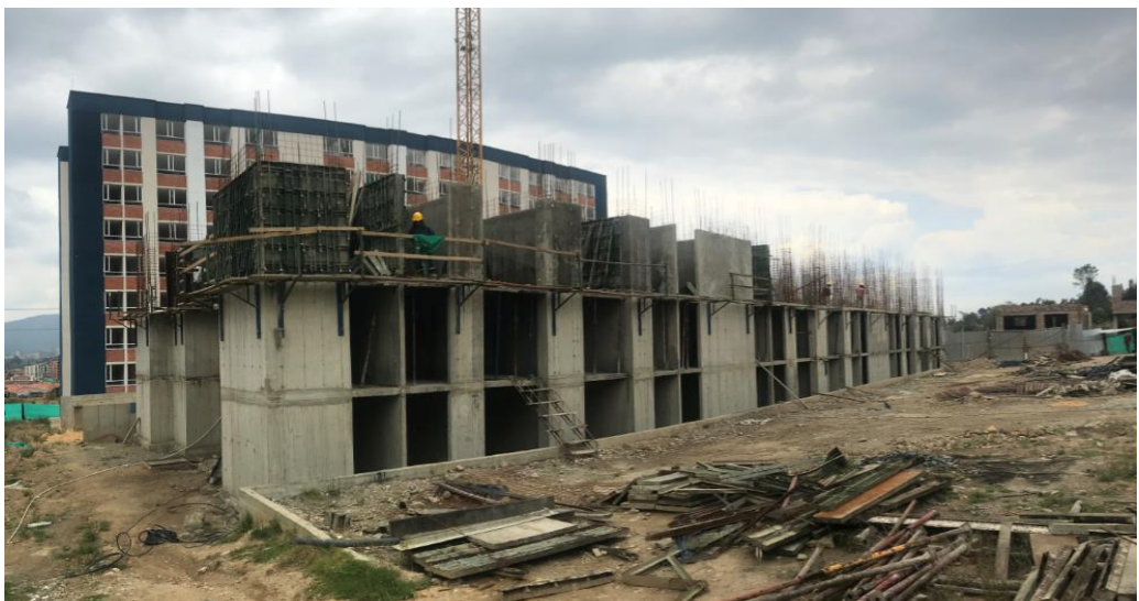
Figura 17. Avance de obra abril 2018
