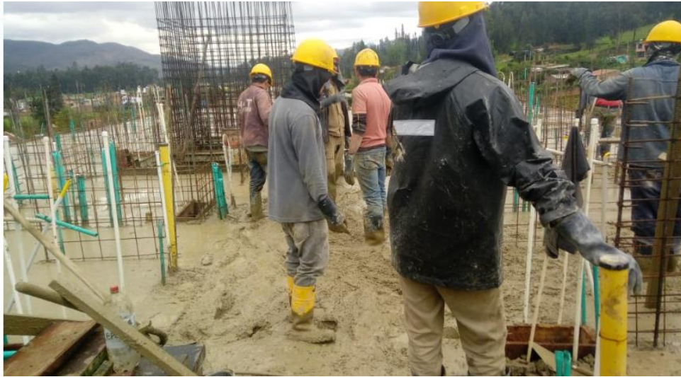
Figura 23. Fundida de placa cuarto piso torre 2
