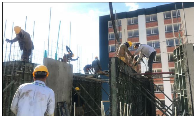
Figura 12.Desencofre de formaleta
