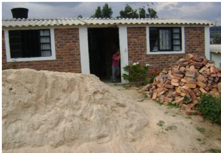
Figura 27. Entrega de materiales para mejoramiento
