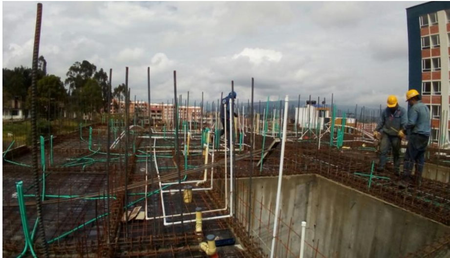
Figura 22. Instalación de tubería eléctrica y sanitaria
