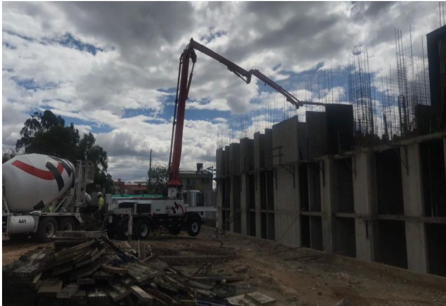
Figura 16. Fundidas muro tercer piso
