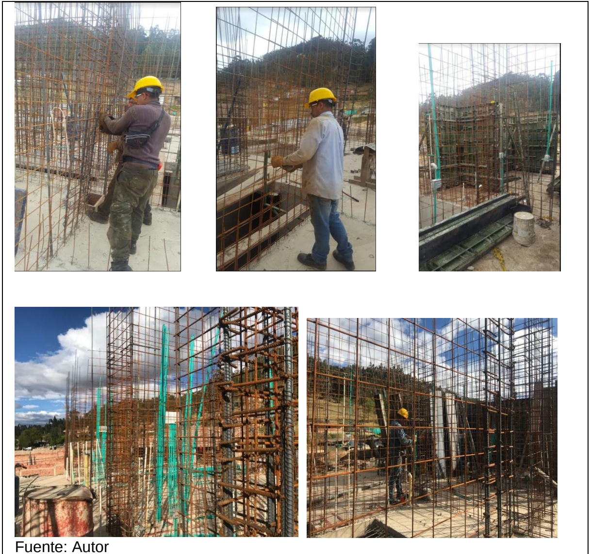
Figura 11. Amarre de dovelas de acero
