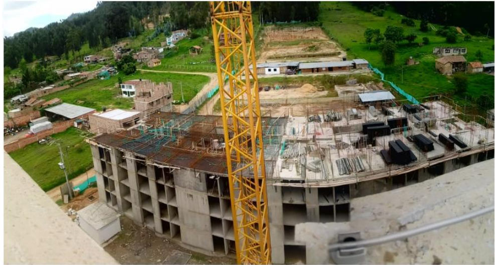
Figura 19. Toma desde torre 1 a placa de cuarto piso sin fundir
