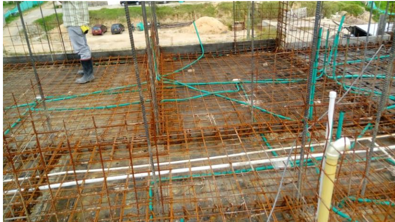
Figura 20. Amarre de acero sección habitaciones y baño
