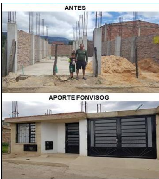
Figura 44. Construcción en sitio propio con avance de obra.
