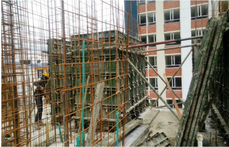
Figura 13. Instalación de formaleta para muros
