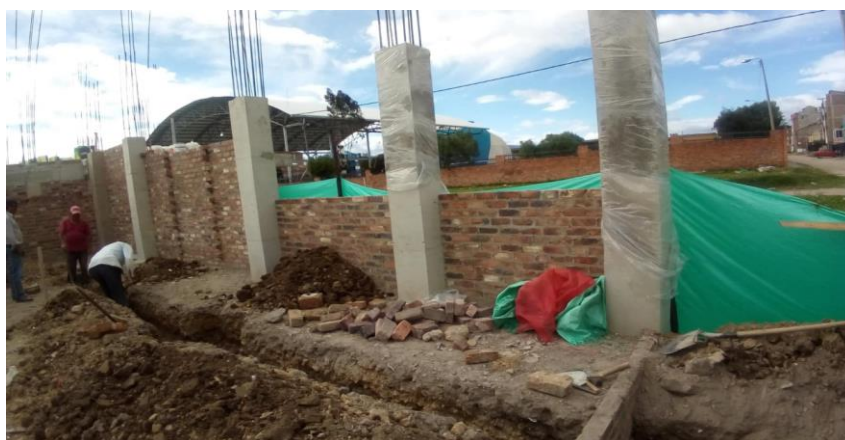
Figura 34. Visita técnica construcción en sitio propio con avance de obra
