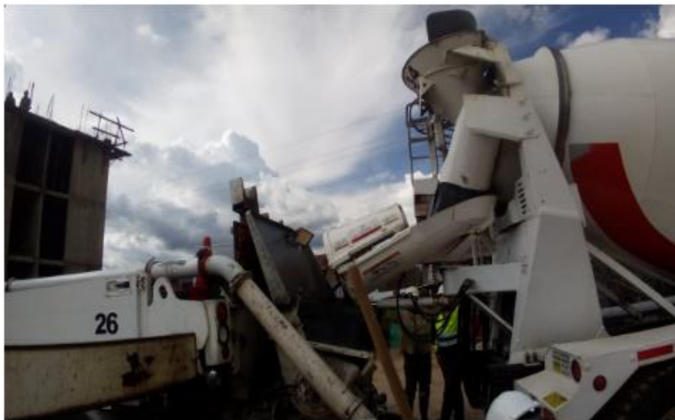
Figura 24. Bombeo y revisión de la mixer
