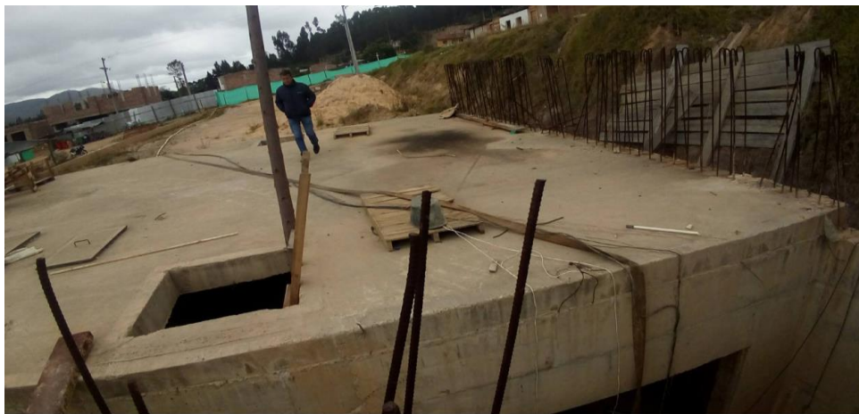
Figura 26. Inspección al tanque de almacenamiento por parte de cooservicios
