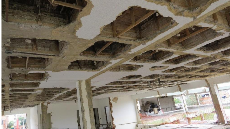
Fotografía 4 Vigas de la edificación, Fuente: propia
