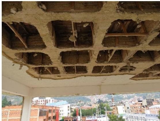
Fotografía 3. Desprendimiento levantado en el paciente, Fuente: Propia
