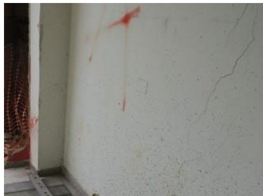
Fotografía 2. Fisura levantada en el paciente, Fuente: Propia
