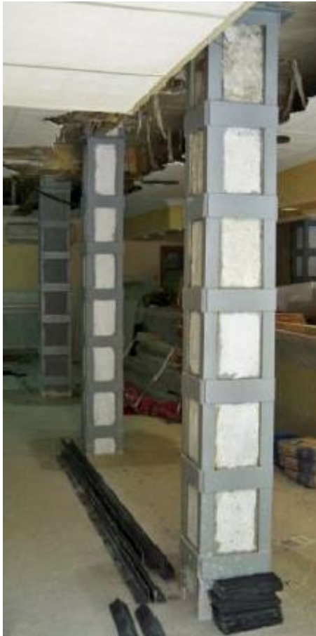
Ilustración 22. Encamisado de columnas, Fuente: Izquierdo, 2015
