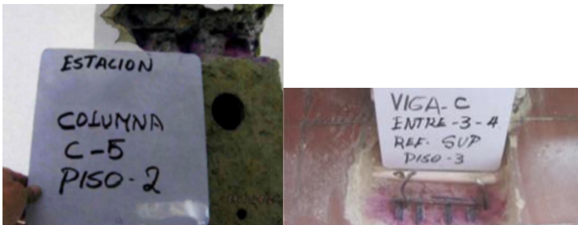
Fotografía 7 Regatas en elementos estructurales (Columnas y vigas)
