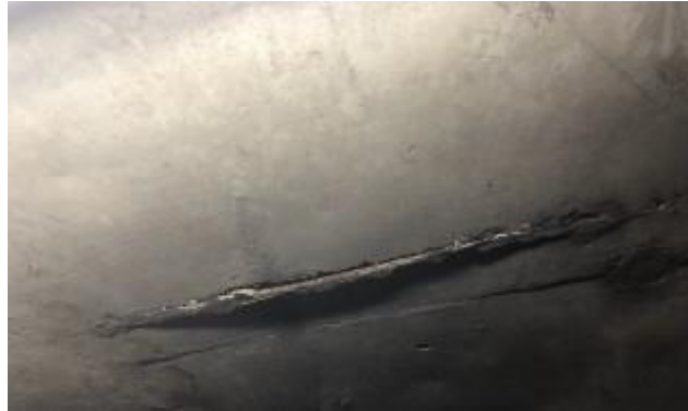
Fotografía 5. Corrosión levantada en el paciente. Fuente: Propia
