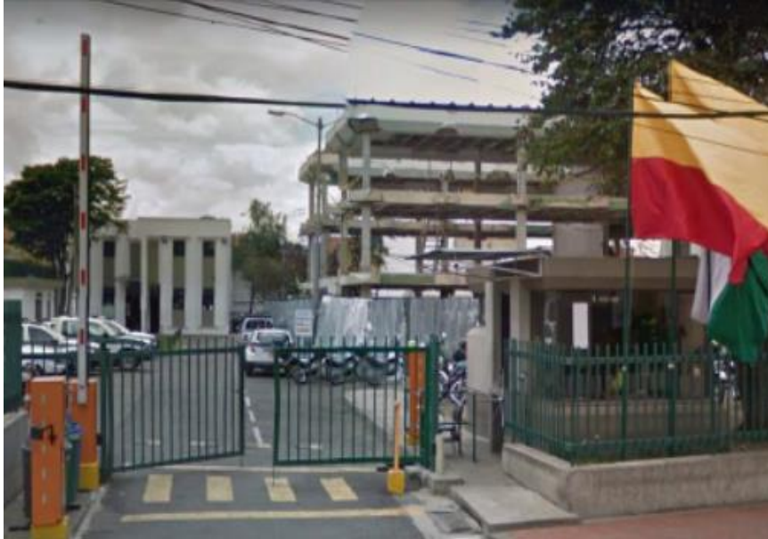
Fotografía 1 Vista global de la edificación, Fuente: Policía Nacional de Colombia
