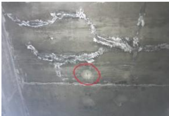
Fotografía 4. Eflorescencia levantada en el paciente, Fuente: Propia
