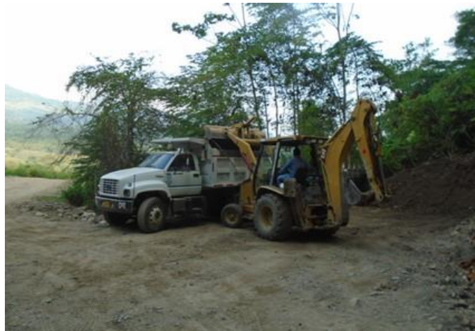
Figura 8. Retiro de escombros en la vía Buenos Aires
