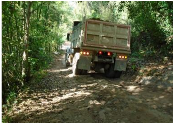
Figura 9. Traslado de escombros
