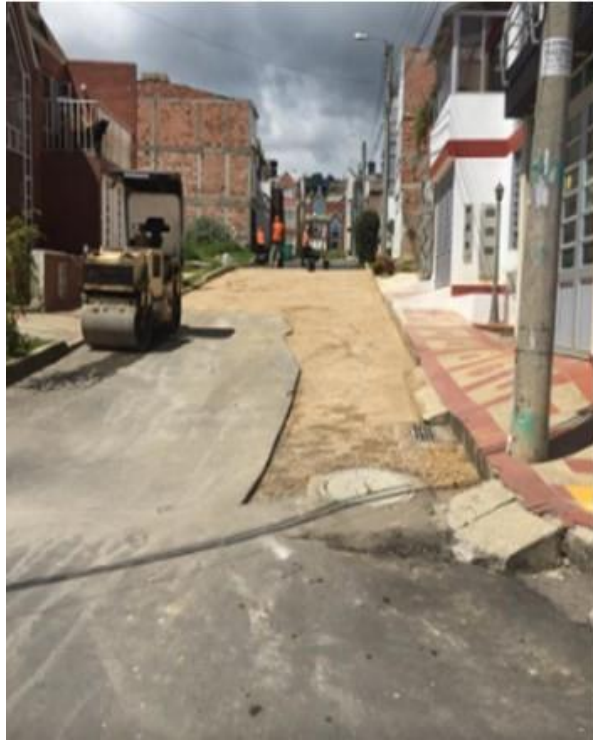
Figura 20. Base granular, (Barrio balcones de terranova.)
