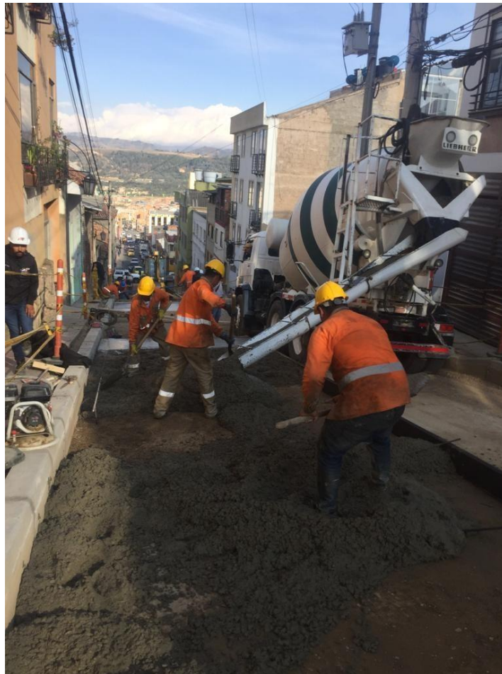
Figura 60. Concreto de 4000 Psi (28 Mpa).
