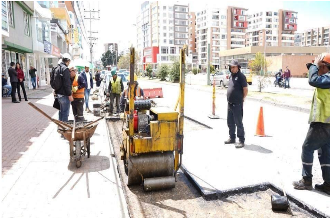
Figura 21. Afirmado sub-base- base granular, (Av. universitaria)
