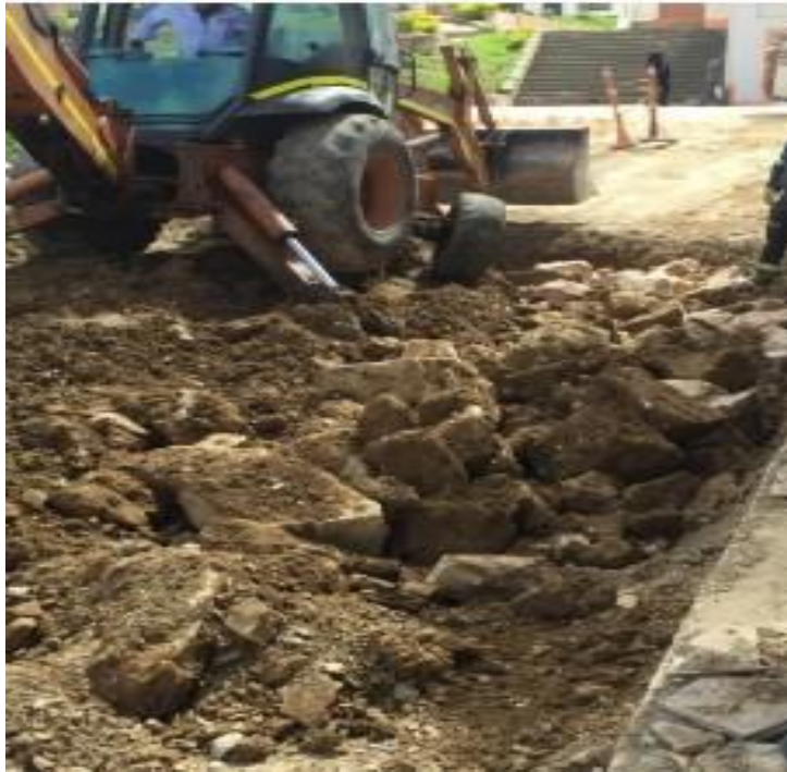
Figura 11. Extracción de material saturado.
