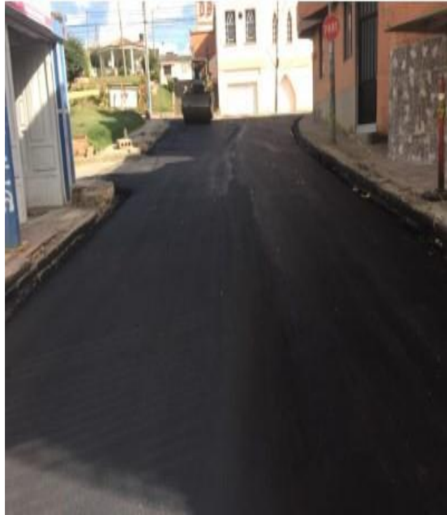
Figura 19 Compactación de carpeta asfáltica.
