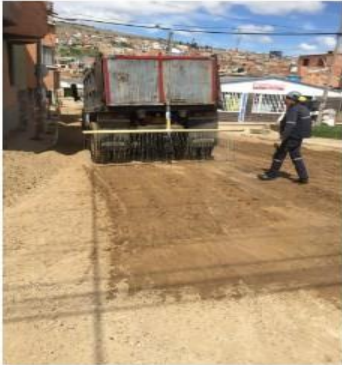
Figura 14 Compactación de base granular.
