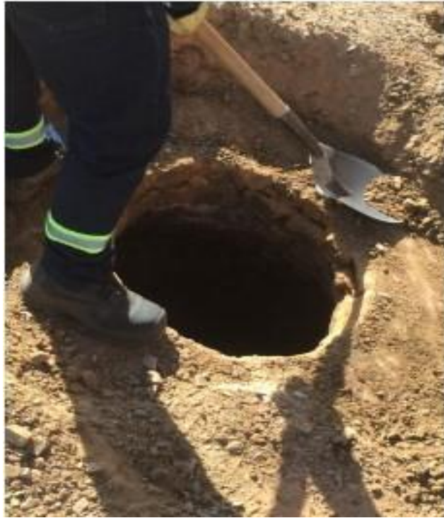
Figura 15 Construcción de alcantarillado sanitario.
