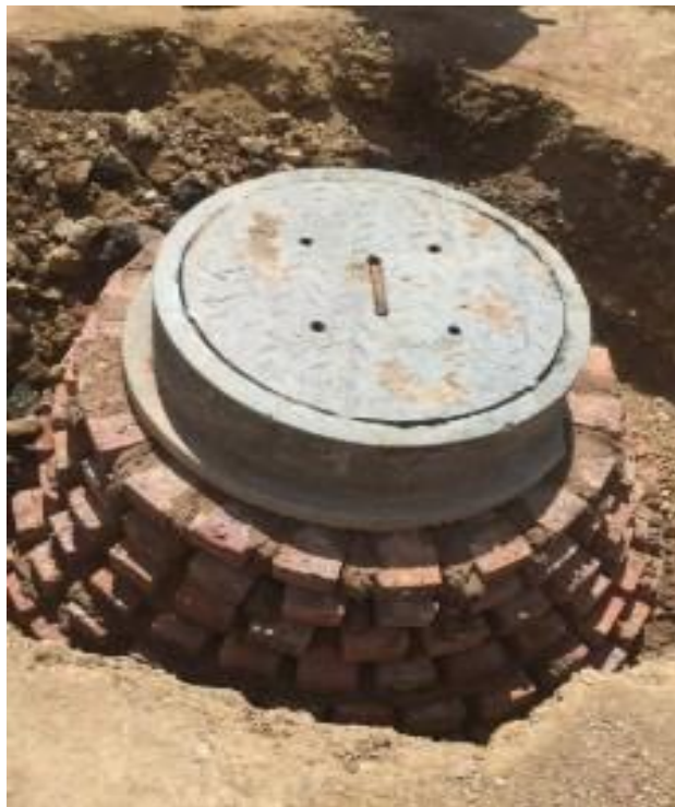
Figura 16 Instalación de tapa de alcantarillado sanitario.
