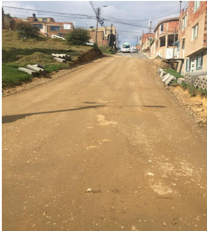
Figura 32 Compactación base granular.
