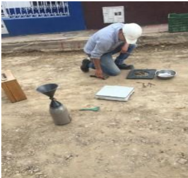
Figura 12 Prueba de densidad de sub-base granular.
