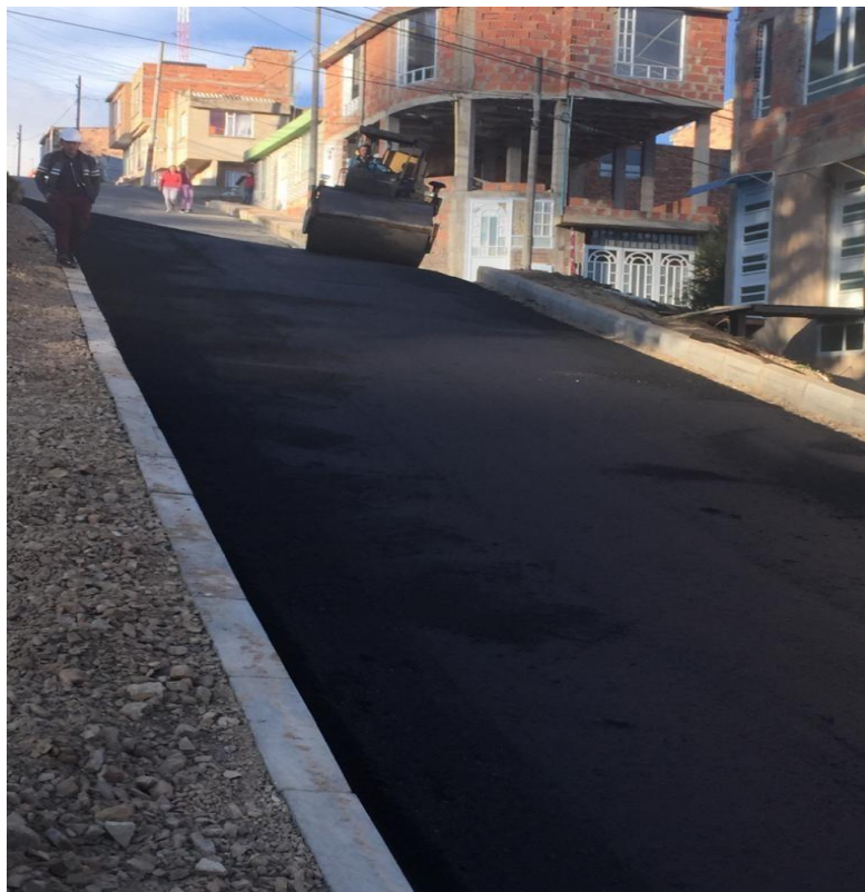
Figura 34 Compactación de carpeta asfáltica.
