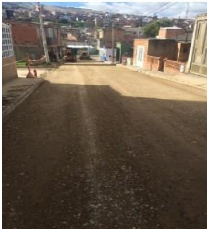
Figura 14 Compactación de base granular.
