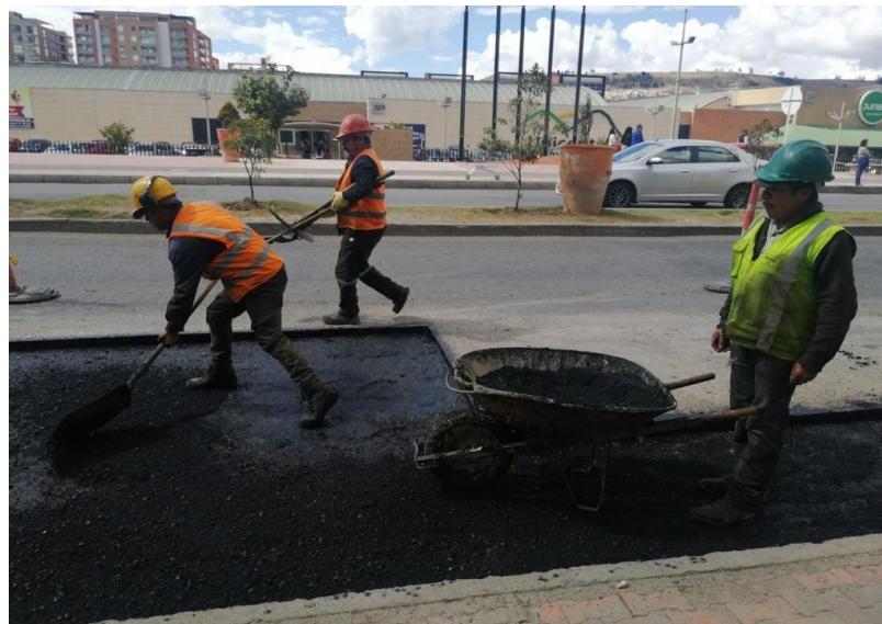
Figura 24. Riego de emulsión asfáltica lenta.
