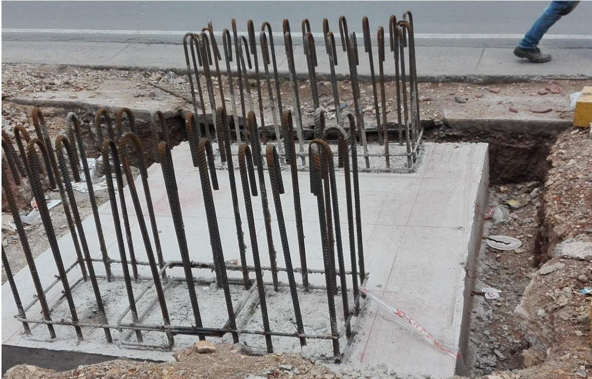
Puente peatonal Barrio Jordán
