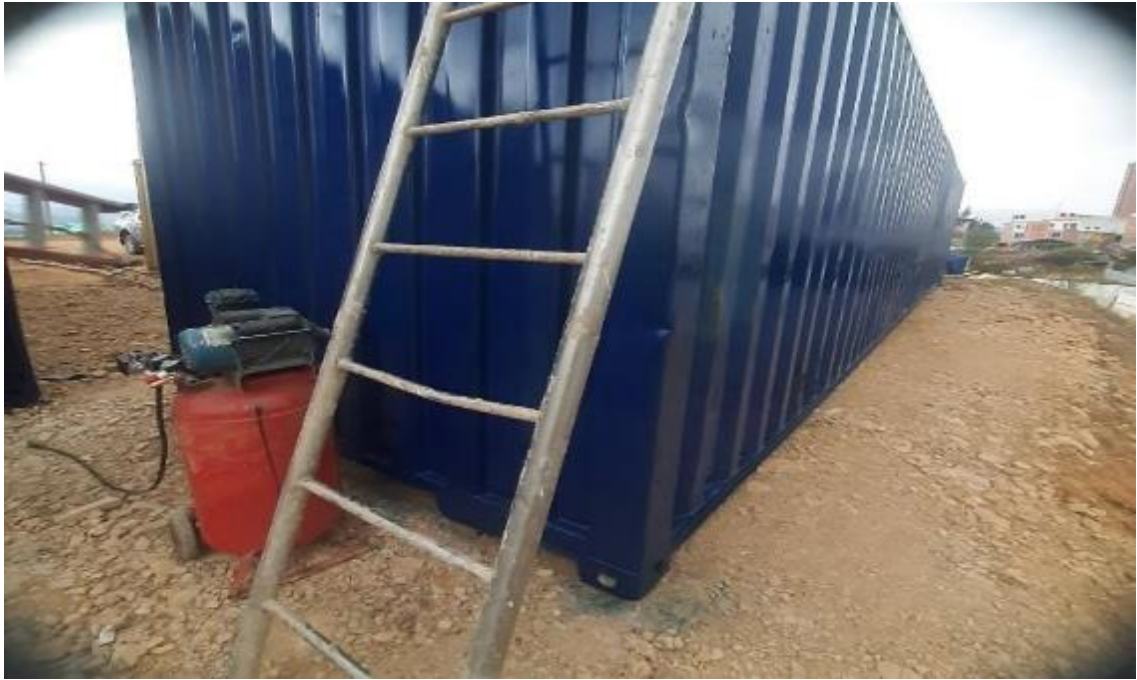
Ilustración 22. Trabajo de mejoramiento y pintura en contenedor
