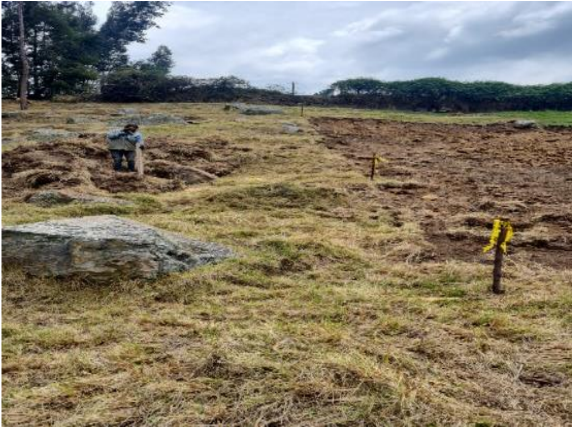
Ilustración 4. Seriado o demarcación del terreno
