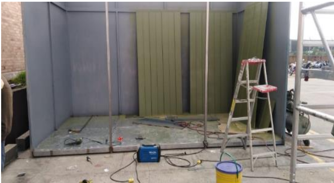
Ilustración 18. Construcción De Shut De Basura
