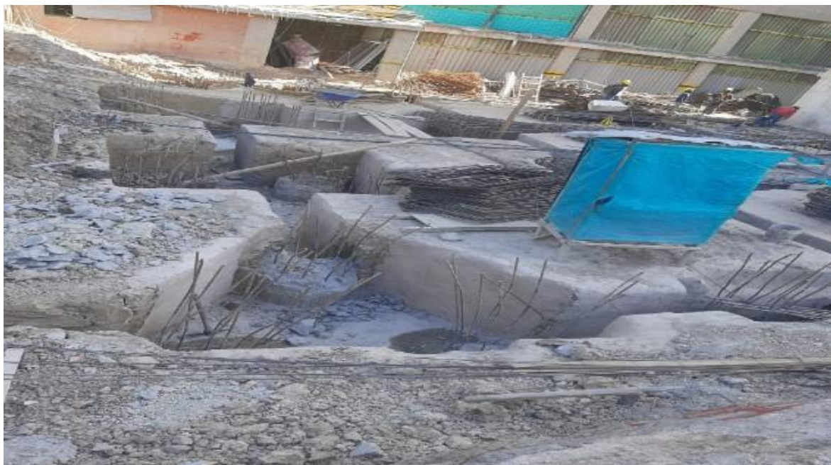
Ilustración 10. Cimentación tipo dado proyecto Alameda de Unicentro
