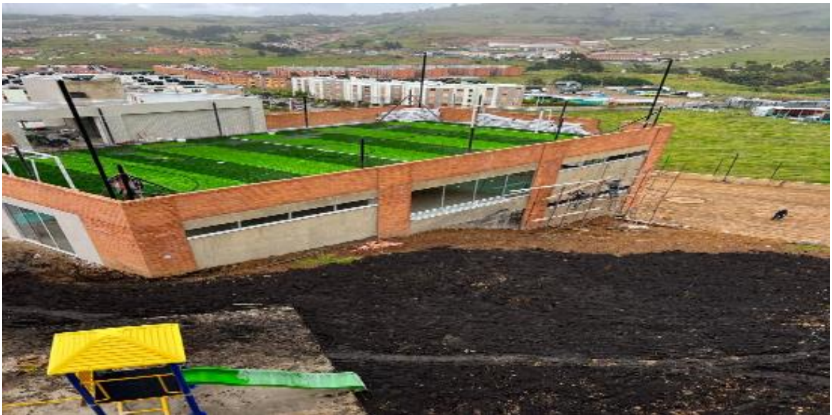
Ilustración 14. Relleno con tierra negra para emperadización.
