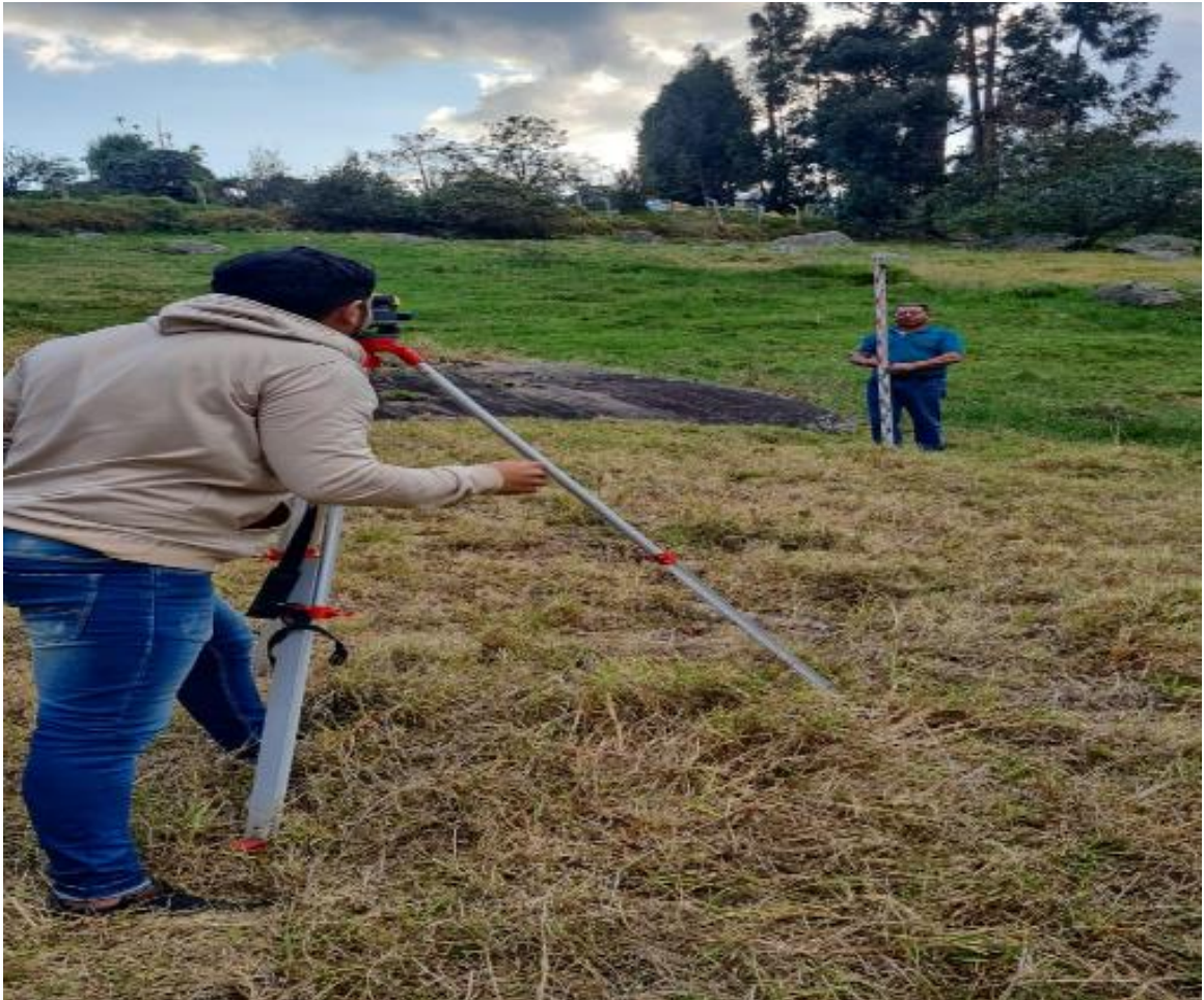
Ilustración 3. Toma de niveles en terreno sin descapotar
