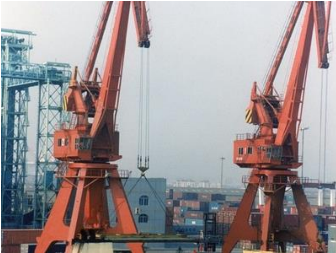
Ilustración 21. Vista panorámica Puerto de Dalian. AÑO: 2020
