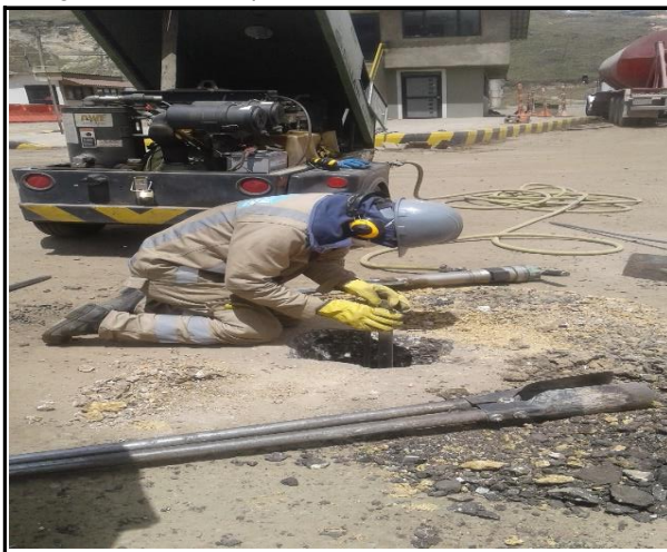
Fotografía 3. Vista general del apique
