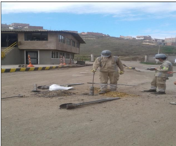
Fotografía 3. Vista general del apique
