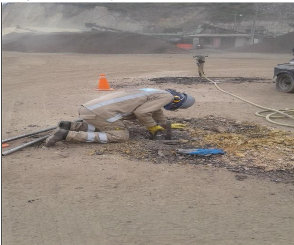
Fotografía 3. Vista general del apique
