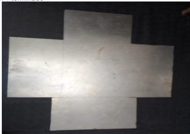
Figura 30 Molde de cajón 1 terminado
