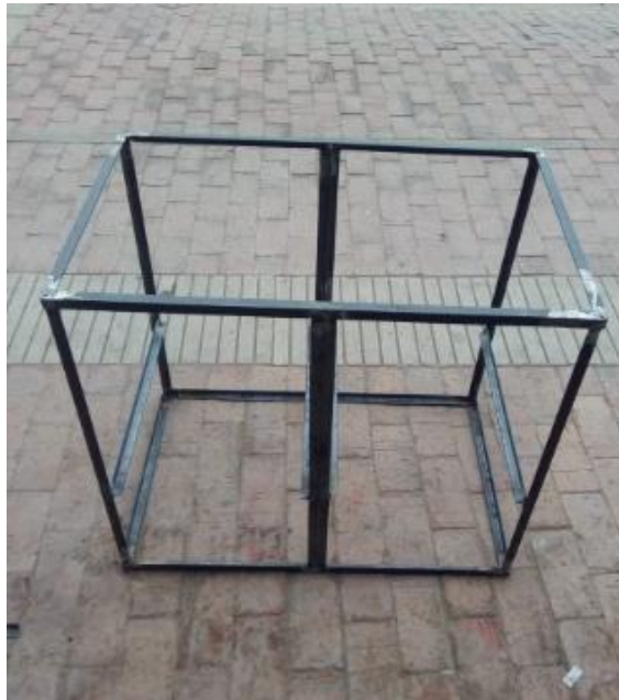
Figura 21. Instalación rieles inferiores
