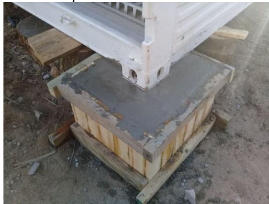
Figura 48. Ejemplo fundición de la zapata
