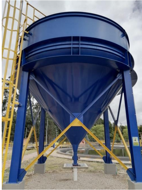
Img 13. Estructura del espesador 1 del módulo 2. Fuente: Autor
