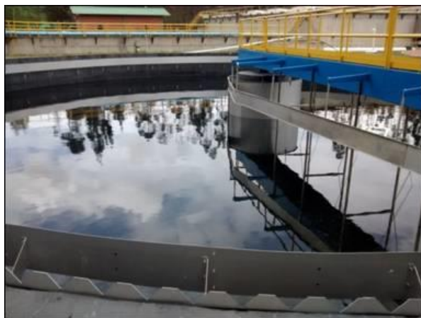
Imagen 8. Sedimentadores Fuente: Gonzales S, Barahona D, Moreno J
