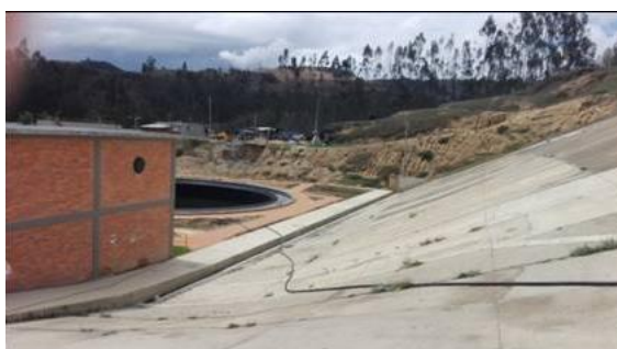
Imagen 2. Talud estabilizado (concreto y pilotes)
