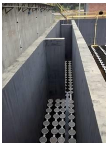
Imagen 7. Estructura para reducir velocidad al flujo del agua Fuente: Gonzales S, Barahona D, Moreno J
