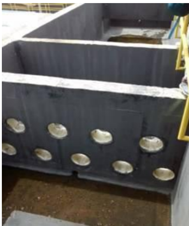
Imagen 3. Desarenador Fuente: Gonzales S, Barahona D, Moreno J
