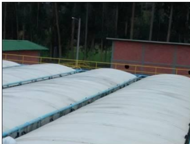
Imagen 4. Tanque UASB
