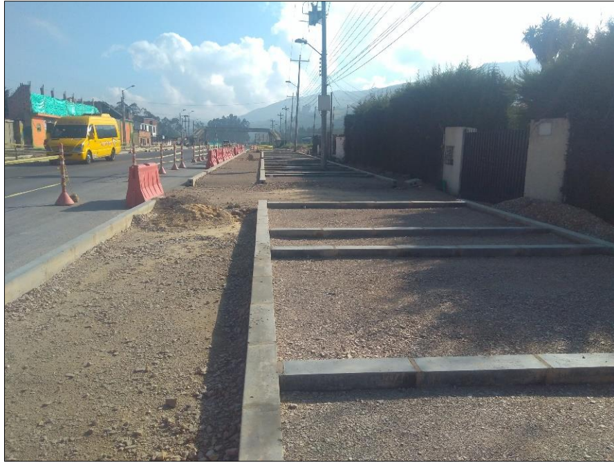
Imagen 53 Instalación bordillo A-80 sector la trampa
