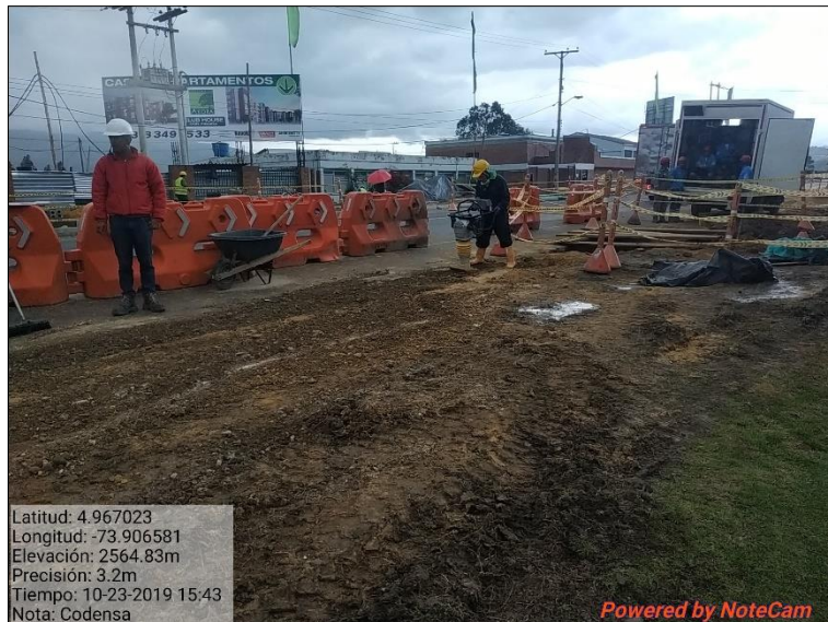
Imagen 8 Compactación material de relleno carrera 4
