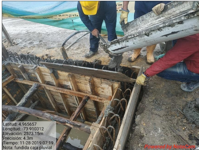
Imagen 37 Fundida concreto paredes caja de inspección sector el hospital
