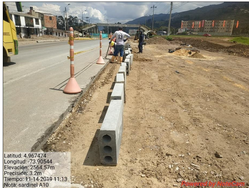
Imagen 50 Instalación sardinel A10 sector la trampa
