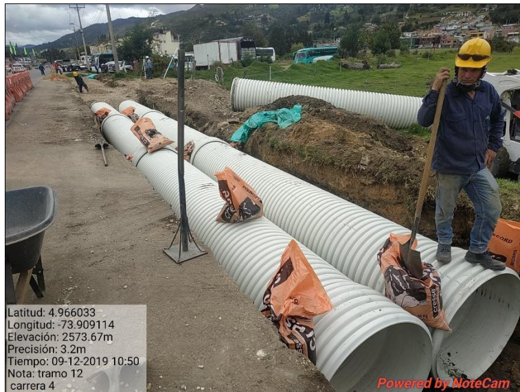
Imagen 18 Tubería en pacha de 36" sector cerezos
