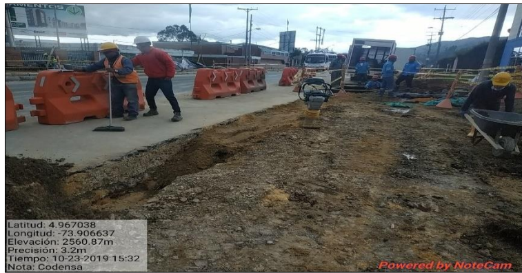
Imagen 7 Relleno con recebo carrera 4
