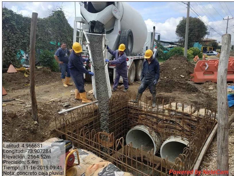
Imagen 32 Vaciado concreto caja de inspección sector la trampa
