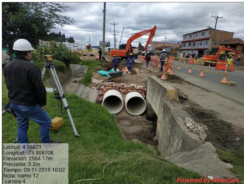
Imagen 17 Tubería en pacha de 36" sector cerezos
