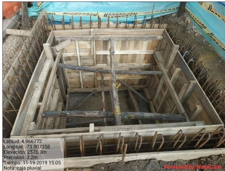
Imagen 34 Formaleta paredes caja de inspección sector la diana
