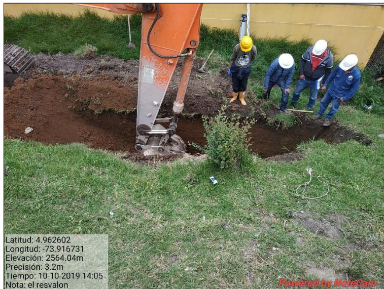
Imagen 19 Excavación tubería sencilla sector el resbalón
