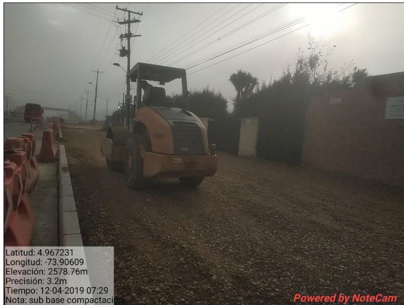
Imagen 46 Compactación material sub base granular sector la trampa
