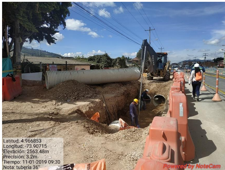
Imagen 57 Tubería sencilla sector la trampa
