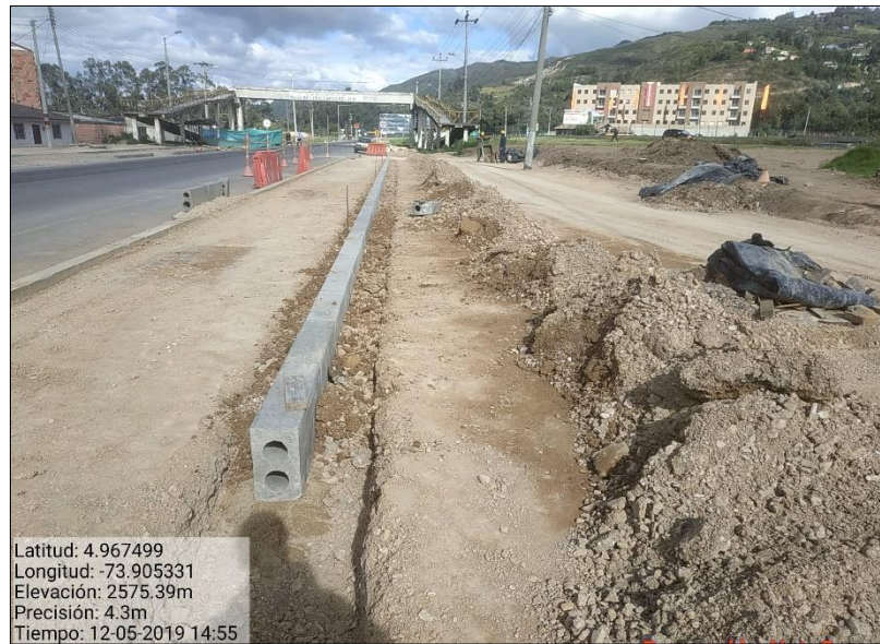
Imagen 51 Instalación bordillo A-80 sector la trampa
