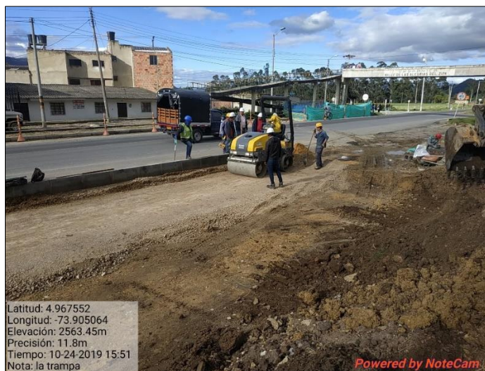
Imagen 45 Compactación material sub base granular sector la trampa
