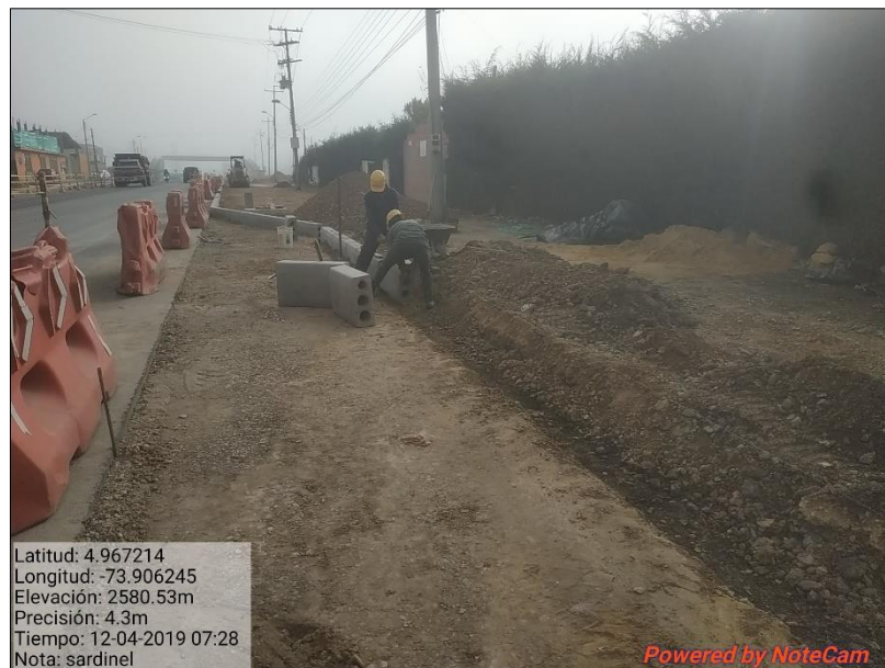
Imagen 49 Instalación sardinel A10 sector la trampa
