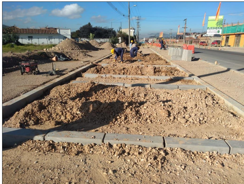
Imagen 52 Instalación bordillo A-80 sector la trampa
