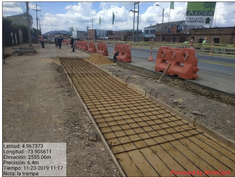
Imagen 38 Acero refuerzo cárcamo sector la trampa
