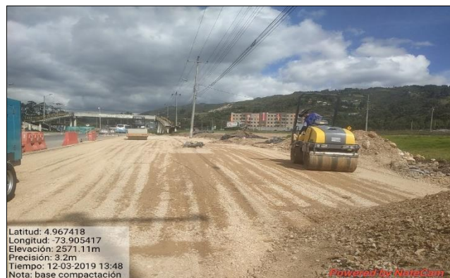
Imagen 48 Compactación material base granular sector la trampa
