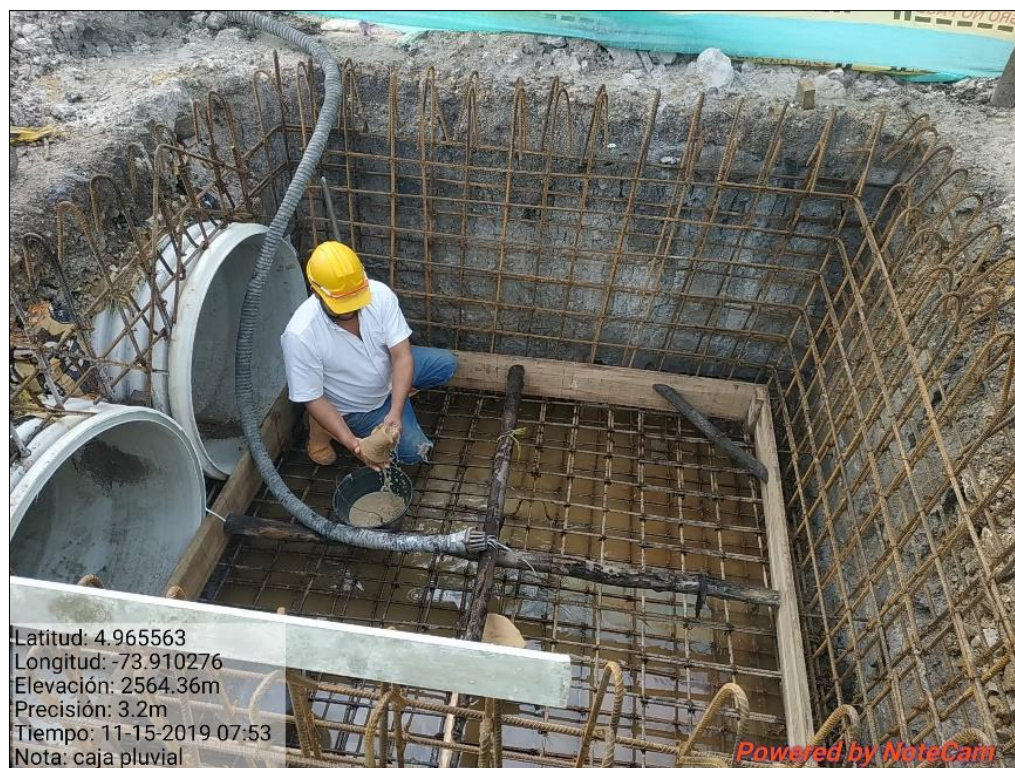
Imagen 31 Bombeo de agua caja de inspección sector la diana
