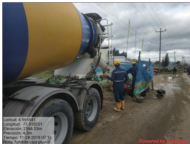
Imagen 35 Fundida concreto paredes caja de inspección sector el hospital
