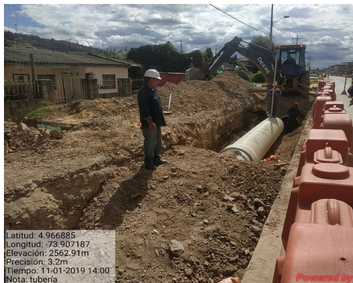
Imagen 58 Tubería sencilla sector la trampa
