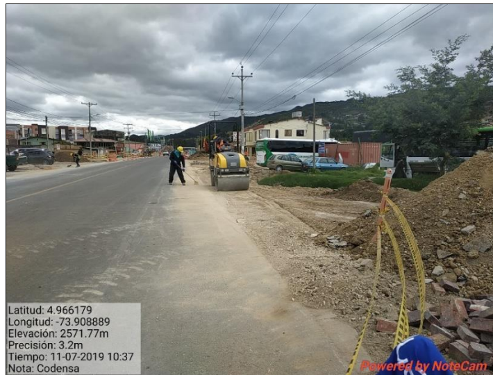
Imagen 9 Compactación material de relleno carrera 4
