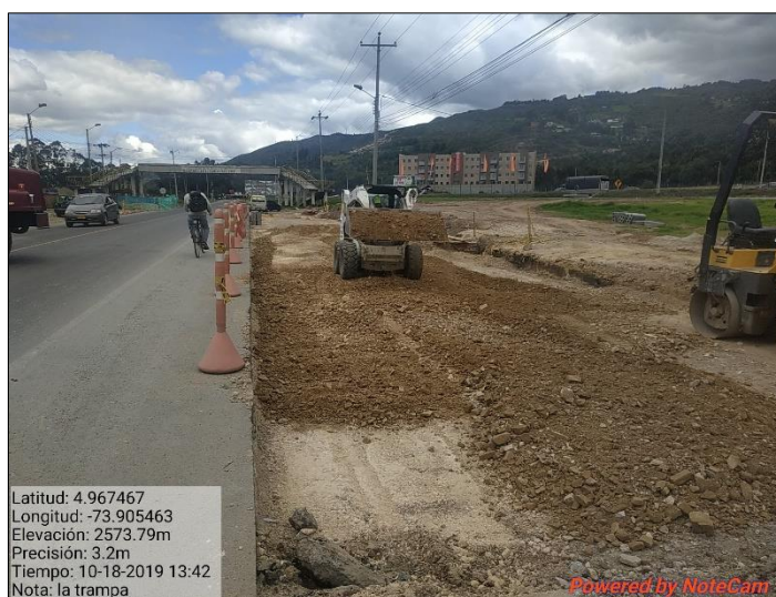
Imagen 44 Extensión material sub base granular sector la trampa
