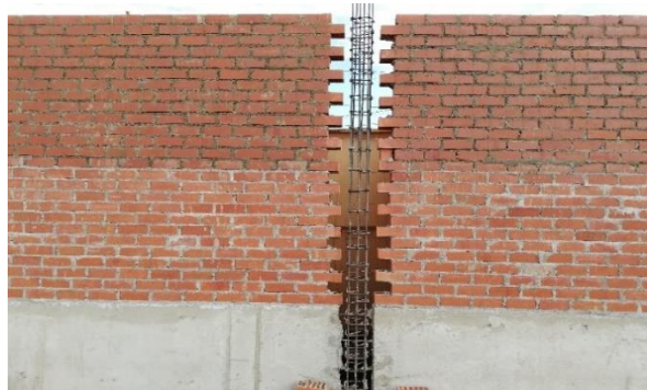
Muro de SOGA ladrillo K.K. de 18 huecos de 9.5 \times 14 \times 24 \text{ cm} , con C-A, 1:4: E = 1.5 \text{ cm} .
