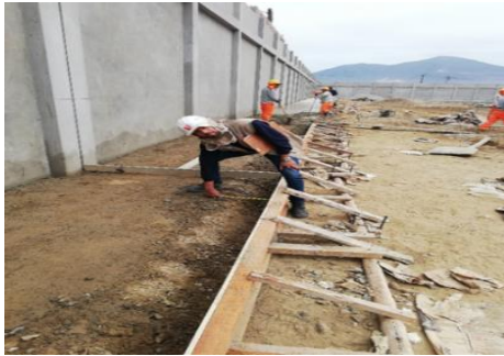
Excavación manual de uña para vereda. Prof.: 30cm
