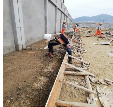
Verificación dimensiones de excavación de uña para vereda de circulación. Av. Costanera.
