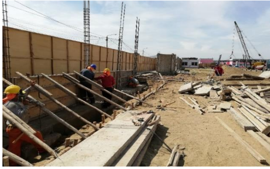
Encofrado normal sobre cemento para cerco perimétrico, Jr. Casma.
