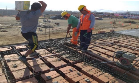
Vaciado de concreto f'c=210 \text{ kg/cm}^2 para losa aligerada SSHH Vestidores Hombres, Av. San Pedro.
