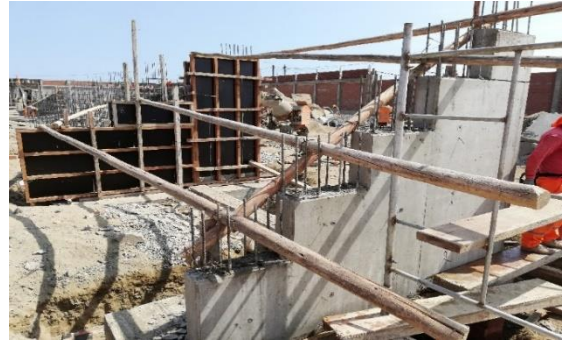
Encofrado tipo cara vista para muros y placas soporte de gradería. Jr. Casma.
