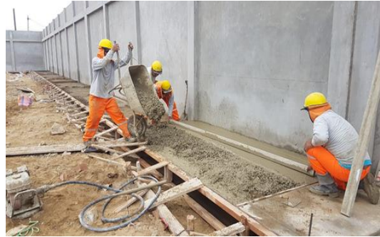
Vaciado de concreto f'c=175 \text{ kg/cm}^2 para vereda de circulación. E=4'' . Av. Costanera.
