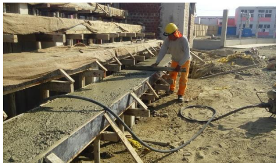
Vaciado de concreto f'c=280 \text{ kg/cm}^2 para graderías Jr. Casma.
