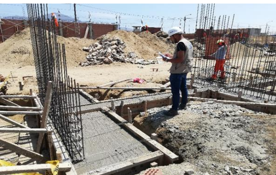
Vaciado de concreto f'c=210 \text{ kg/cm}^2 para vigas de cimentación de gradería.
