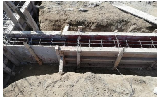
Encofrado normal para vigas de cimentación, graderías Jr. Casma.
