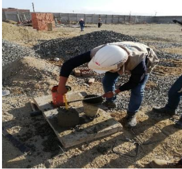
Elaboración de probetas para ensayos de resistencia a compresión y realización de prueba de SLUMP a concreto.
