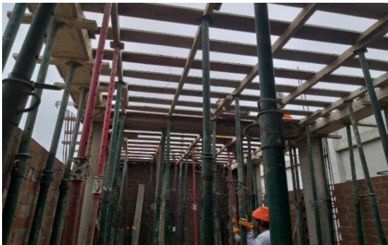
Encofrado normal losa aligerada SSHH Vestidores Hombres, Av. San Pedro.
