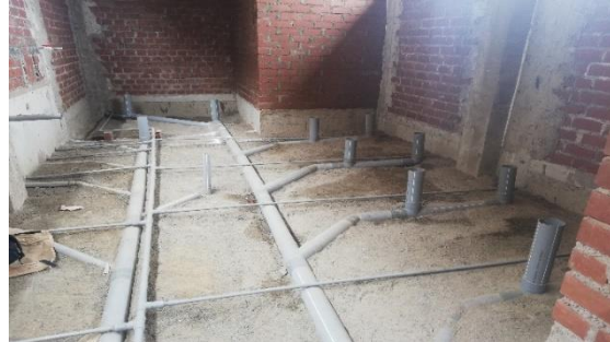
Instalación y pruebas de fugas a instalaciones hidrosanitarias.
