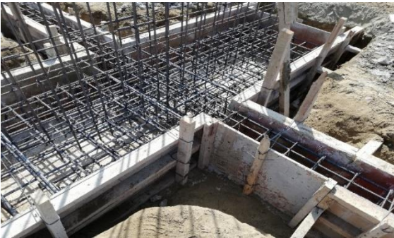
Encofrado normal para zapatas de graderías. Jr. Casma.
