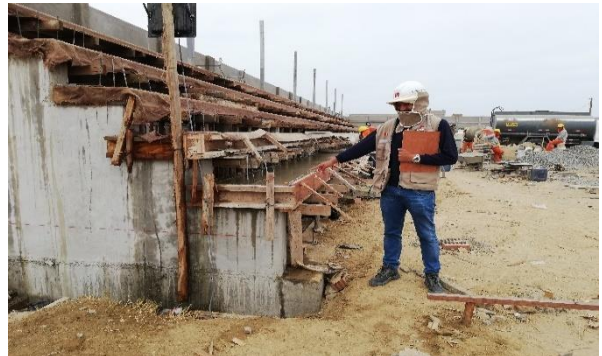
Verificación de altura y enrazado luego de vaciado de concreto f'_c = 280 \text{ kg/cm}^2 gradería Av. San Pedro.
