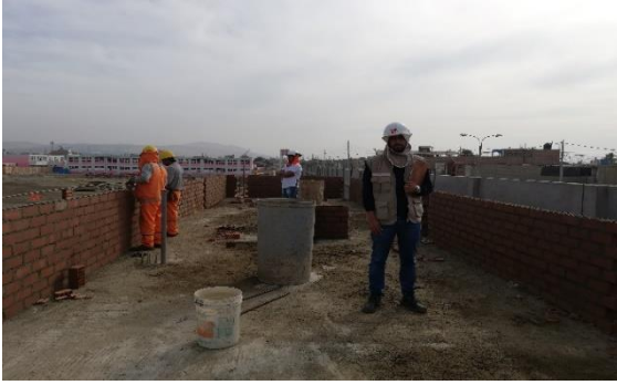
Verificación verticalidad y continuidad en el asentado de muro tipo SOGA, K.K 18 huecos. Parapeto SSHH Vestidores Hombres. Av. San Pedro.
