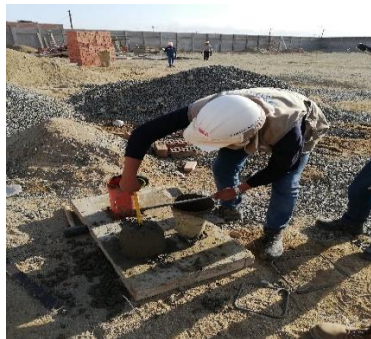
Ilustración 8. Practicante realizando prueba de slump
