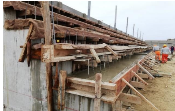
Encofrado normal para graderías. Jr. Casma.
