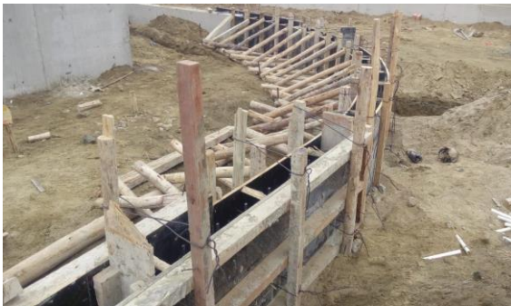
Encofrado tipo cara vista para sardinel peraltado. Jr. Casma.
