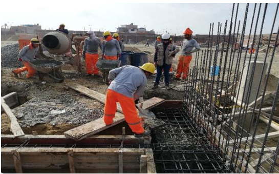
Vaciado de concreto f'c=210 \text{ kg/cm}^2 para zapatas de gradería.
