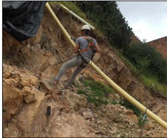
Ilustración 31: Realización de las perforaciones.
