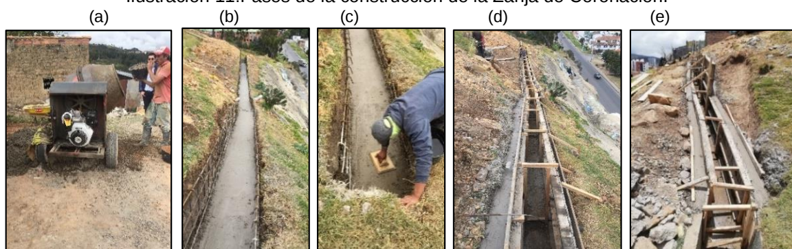
Ilustración 11: Fases de la construcción de la Zanja de Coronación.
