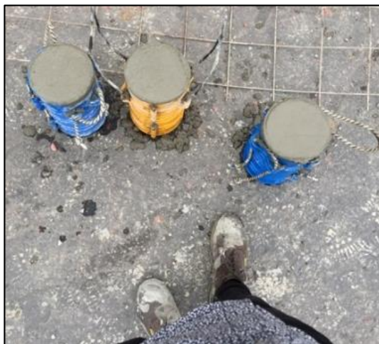
Ilustración 33: Elaboración de Cilindros del concreto lanzado- Talud el Dorado.
