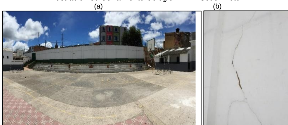
Ilustración 36: Cerramiento Colegio INEM- Sede Piloto.
