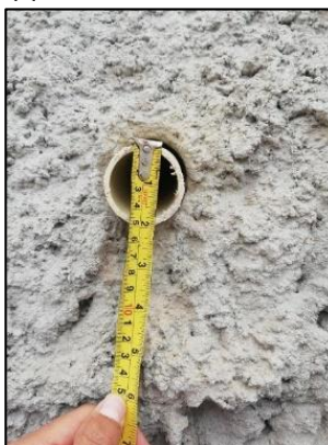
Ilustración 21: Verificación en las medidas de los Drenes.
