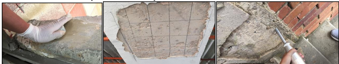
Ilustración 24: Ejecución del ensayo de martillo de rebote o esclerómetro.
