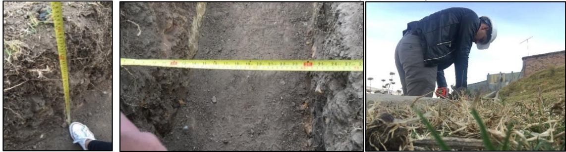
Ilustración 8: Verificación de medidas en la excavación para la Zanja de Coronación.
