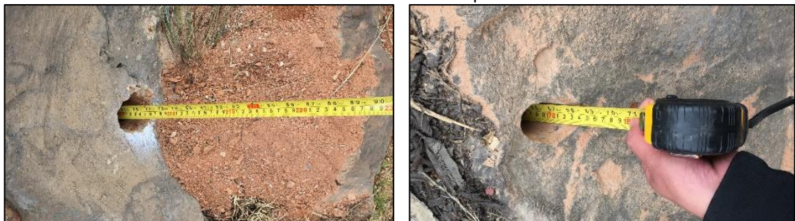
Ilustración 16: Verificación en las profundidades.
