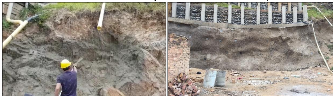
Ilustración 32: Lanzado del concreto y culminación de las obras complementarias.
