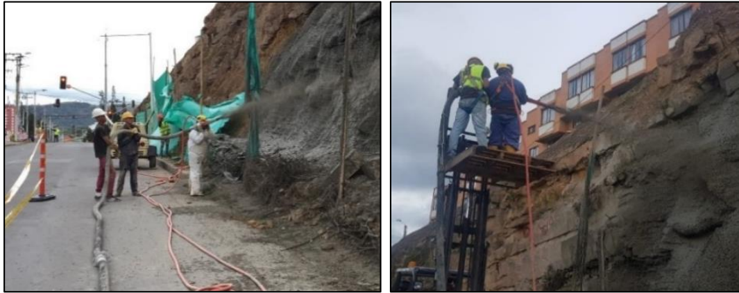
Ilustración 18: Instalación del Concreto Lanzado. (a) Parte Baja del Talud (b) Parte Alta del Talud
