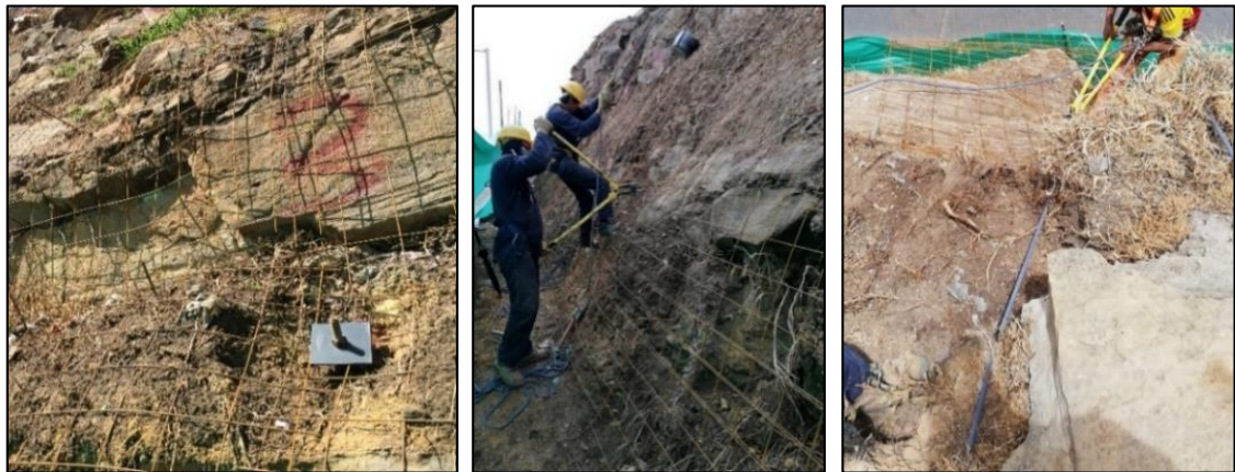
Ilustración 17: Instalación de Malla electrosoldada TS-90.
