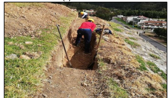
Ilustración 7: Excavación para Zanja de Coronación. (a) (b)
