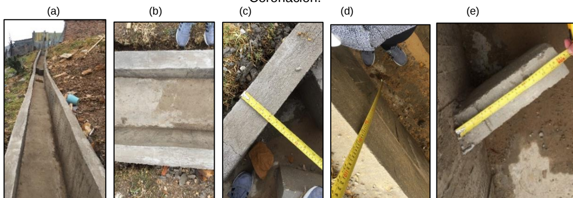
Ilustración 13: Terminación de la construcción y verificación de las medidas de la Zanja de Coronación.
