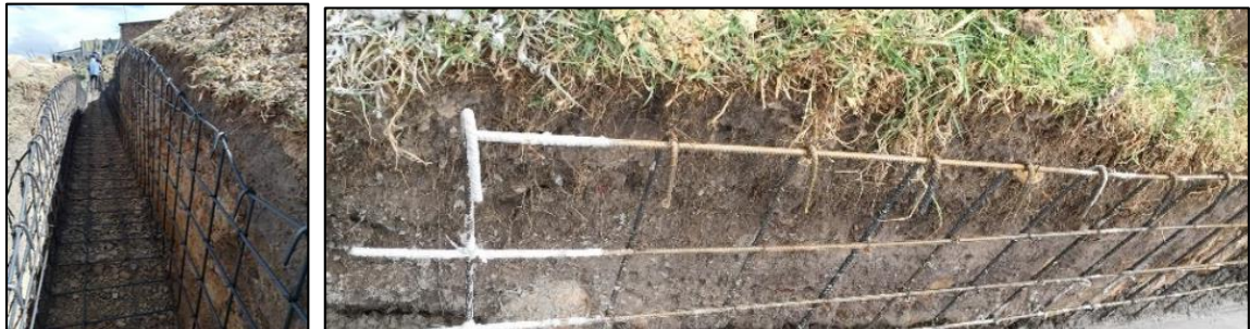
Ilustración 10: Armado del Acero.
