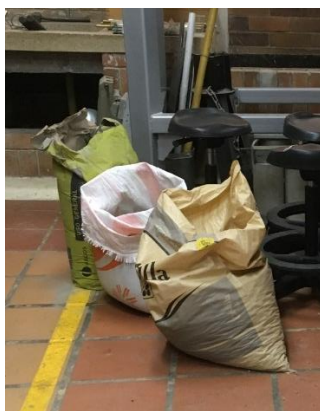
Ilustración 5. Material almacenado para la mezcla.
