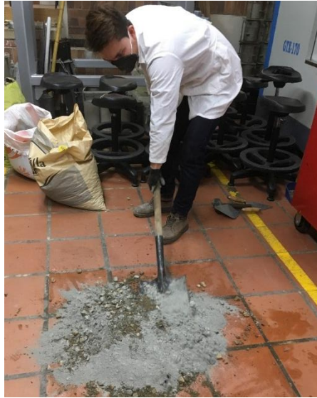
Ilustración 7. Mezcla de materiales en seco.
