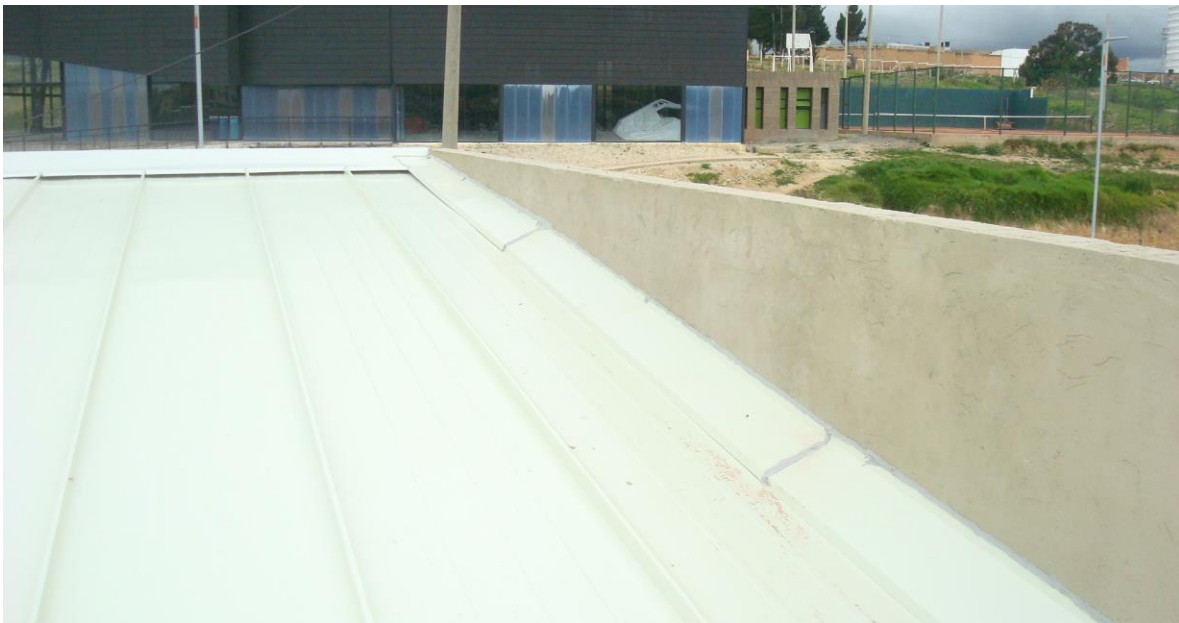
Fotografía 13: Uniones con epóxico.
