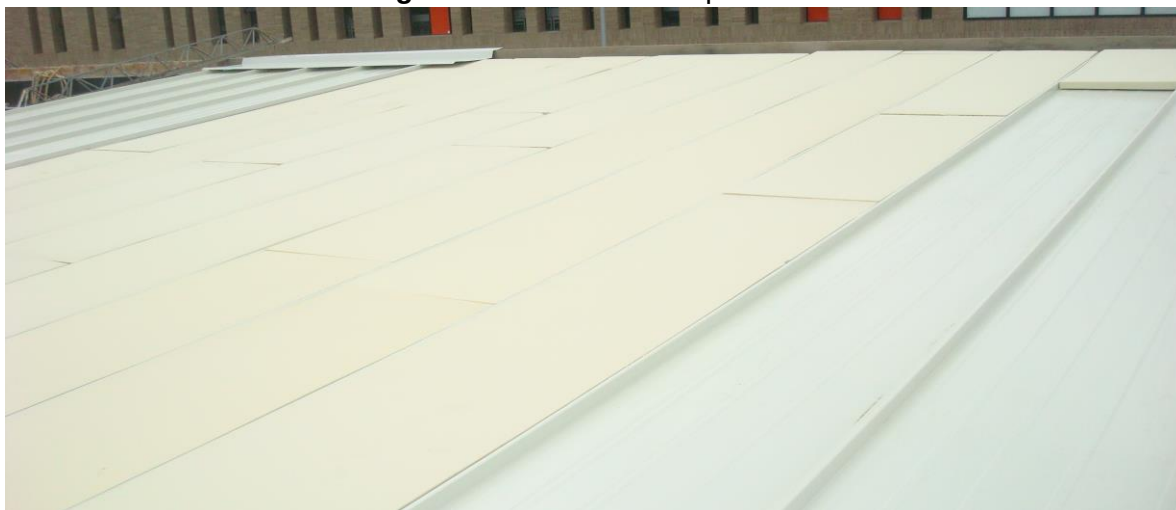
Fotografía 8: Instalación de poliuretano.
