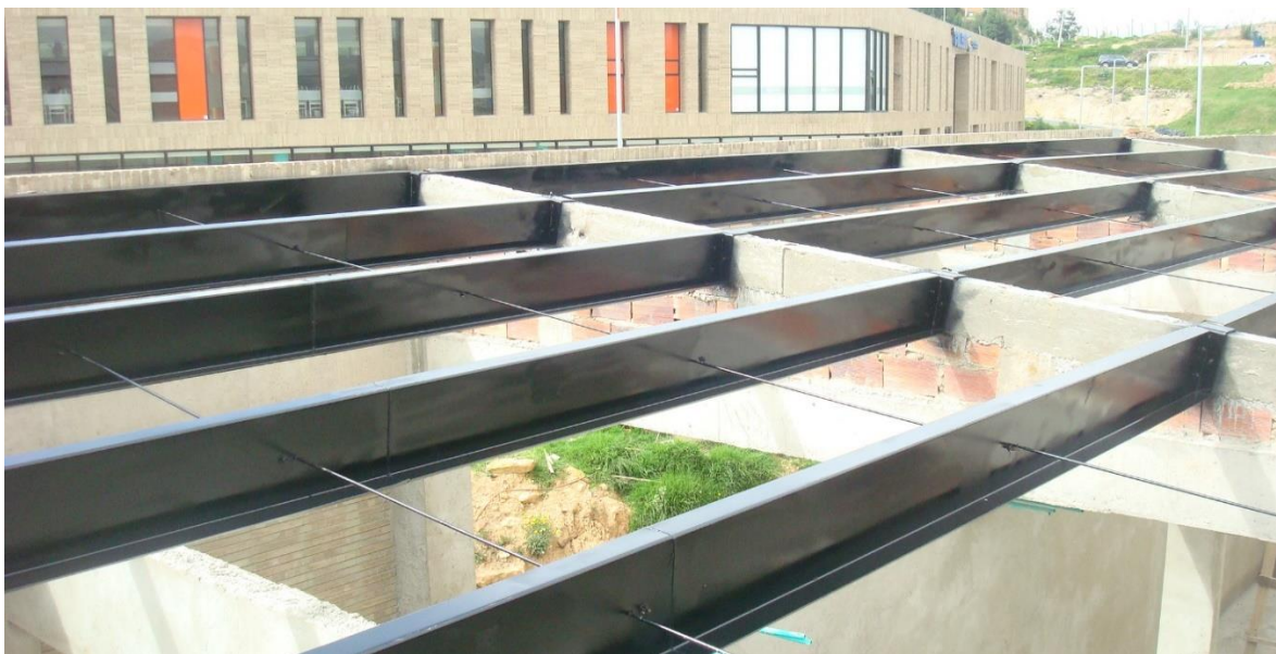
Fotografía 7: Correas metálicas (perfil z).
