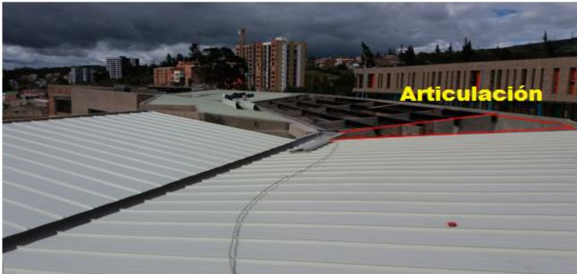
Fotografía 12: Articulación entre bloque 4 y bloque 3.
