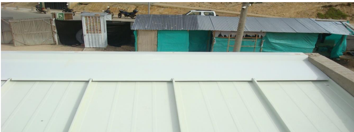
Fotografía 10: Instalación de flanches.
