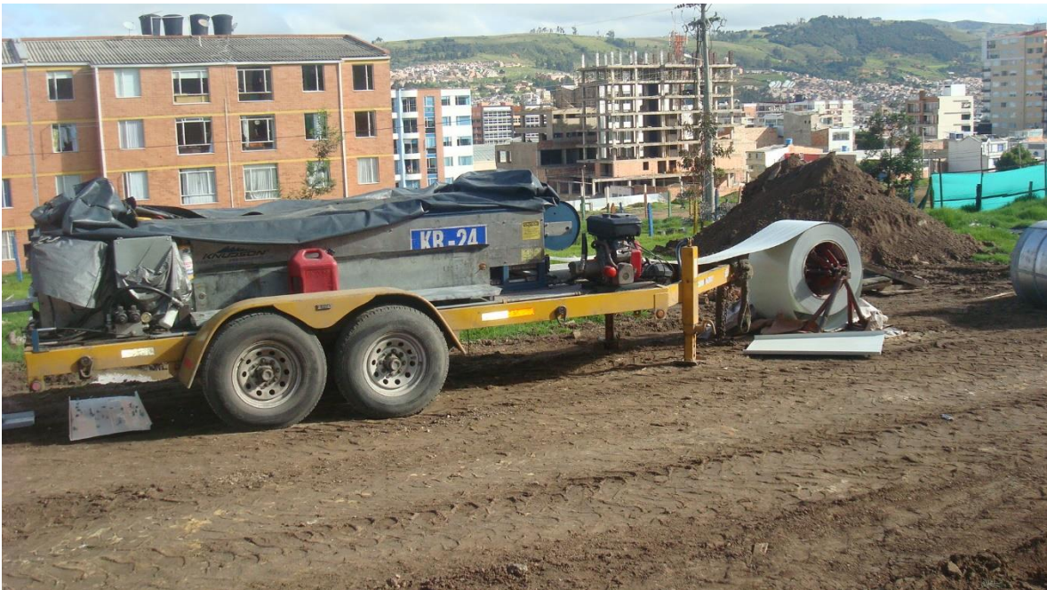
Fotografía 5: Maquina KR-24 alimentada por un rollo de lámina.
