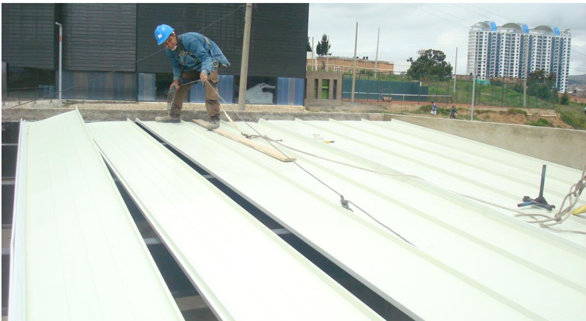
Fotografía 6: Instalación de cubierta.
