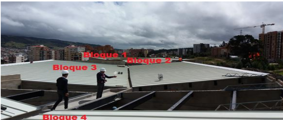
Fotografía 11: Bloques instalación de cubierta.
