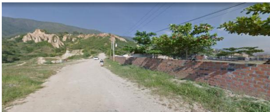
Fotografía 1. Estado de la vía Actual Sur de Acceso al Lote
