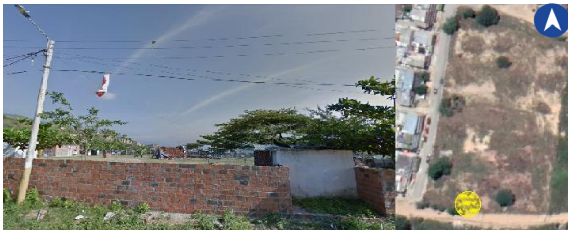
Fotografía 4. Alumbrado público vía veredal la zona Sur
