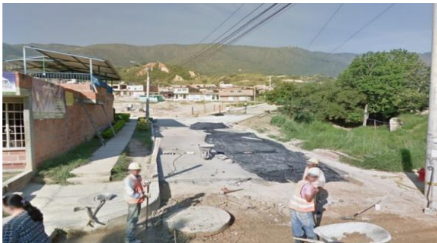
Fotografía 2. Vía en pavimentación de la Calle 35 hacia la Calle 32
