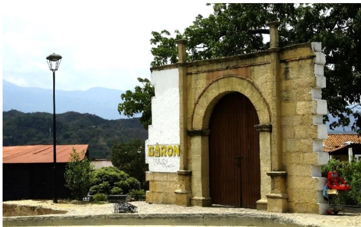
Fotografía 5. Puerta Grande de Girón
