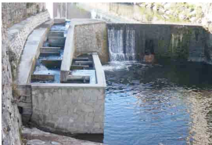
Figura 13. Azud con escala para peces.
