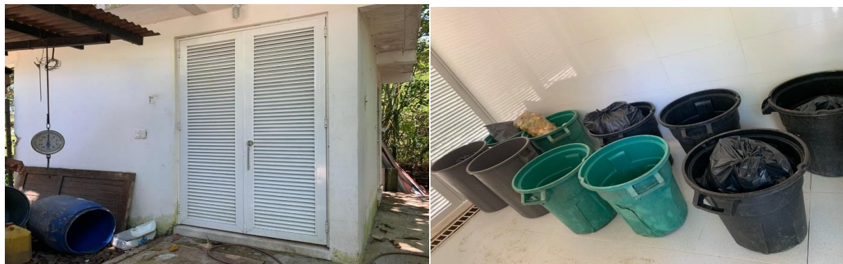
Figura 4. Vista externa e interna de la de la unidad de almacenamiento de residuos ordinarios (Reina y Torres, 2020).
