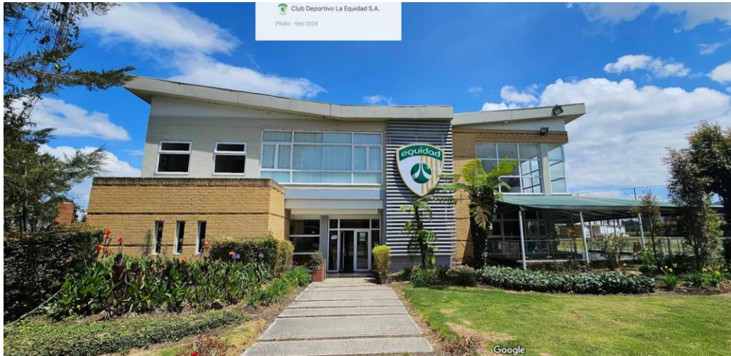
Figura 2. Centro de Alto Rendimiento (CAR), del Club Deportivo La Equidad SA
