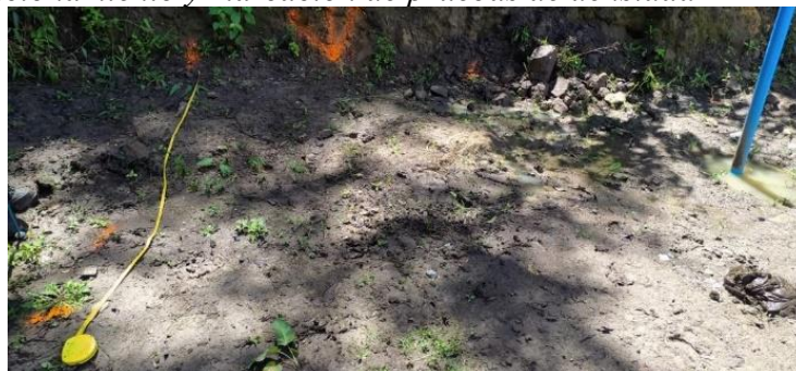
Figura 19. Geoposicionamiento y marcación de pruebas de densidad
