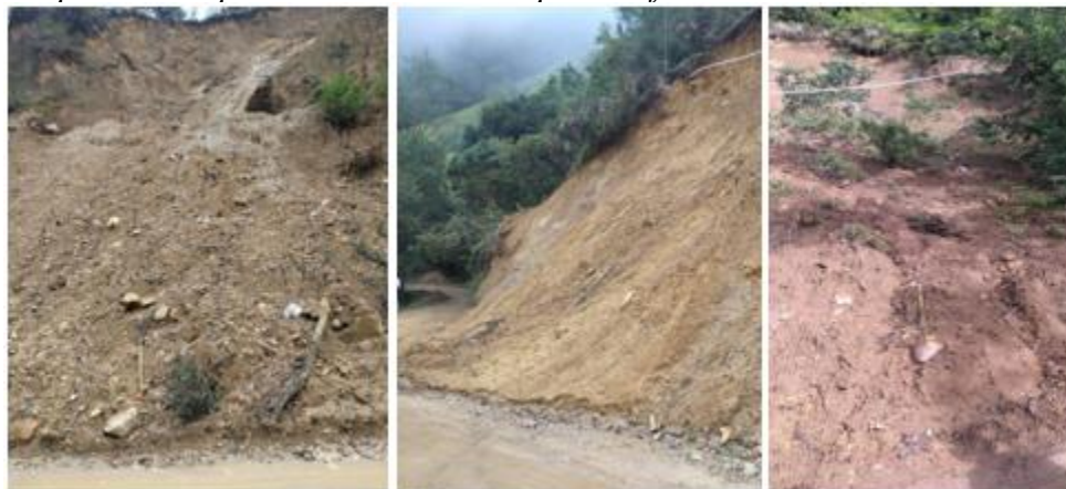
Figura 26. Inspección de puntos críticos Municipio California
