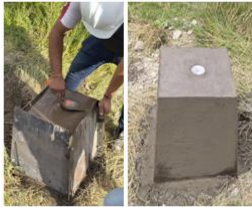
Figura 15. Construcción mojones de topografía
