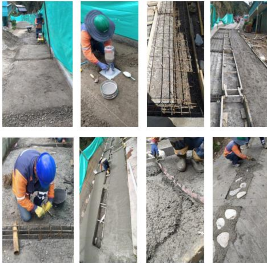
Figura 11. Supervisión procesos constructivos placa huella
