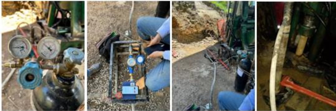
Figura 22. Ejecución de pruebas de permeabilidad lugeon y lefranc
