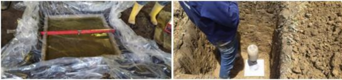
Figura 24. Ejecución pruebas de densidad por cono de arena y reemplazo de agua
