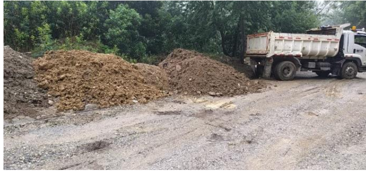
Figura 29. Acopio de material removido
