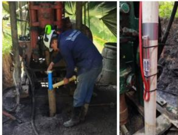
Figura 23. Instalación piezómetros de hilo vibrátil, casa grande
