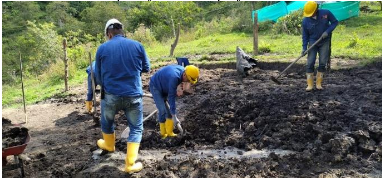
Figura 21. Recuperación ambiental plataformas de perforación
