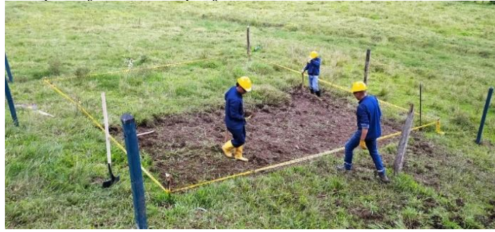
Figura 20. Construcción plataformas de perforación
