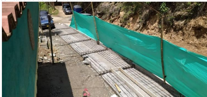
Figura 10. Recorridos de obras placa huella
