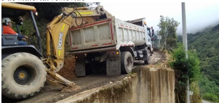
Figura 28. Cargue de material removido
