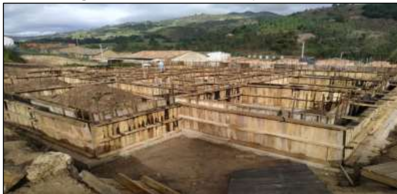
Figura 14 Desencofrado zarpas de cimentación
