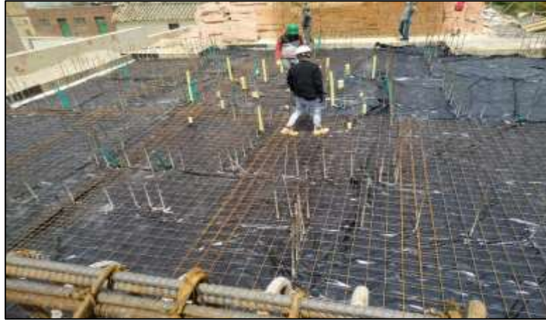
Figura 20 Instalación Malla electro soldada
