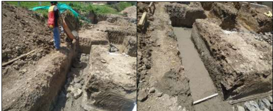
Figura 7 Aplicación concreto ciclópeo en obra
