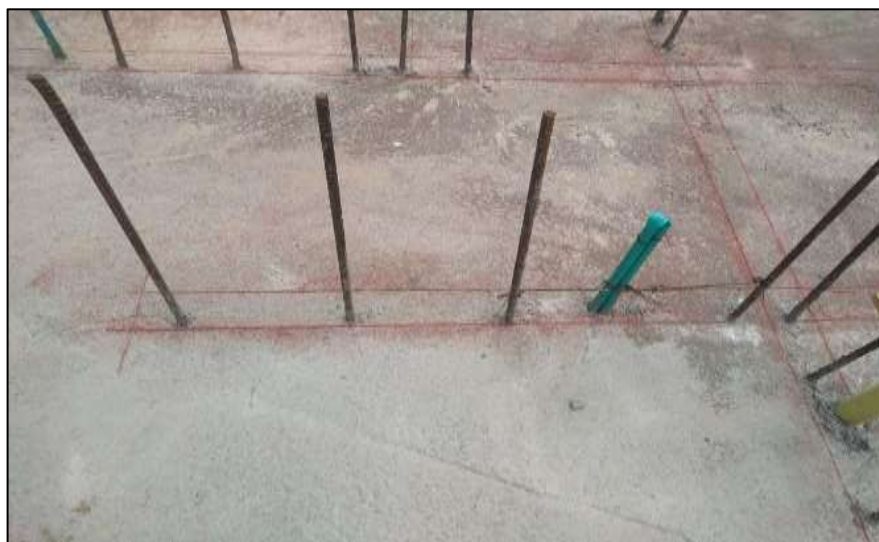
Figura 23 Cimbrado muros en mampostería
