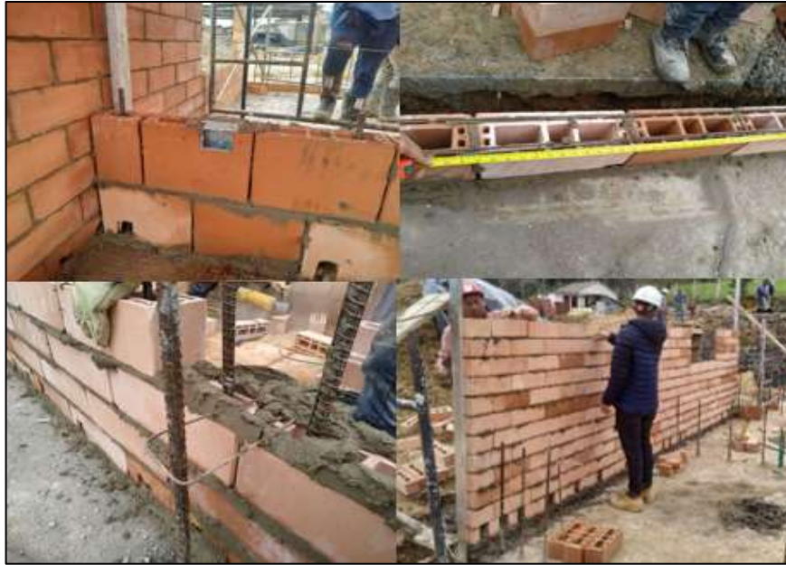
Figura 24 Levantamiento Muros en mampostería
