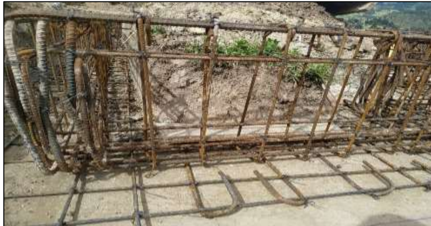
Figura 9 Acero de refuerzo vigas de cimentación
