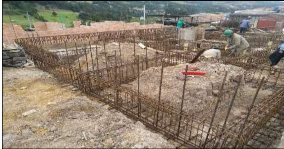
Figura 10 Dovelas instaladas en obra
