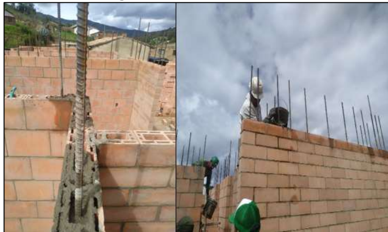
Figura 26 Fundición de dovelas
