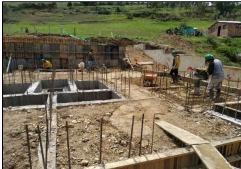
Figura 17 Relleno con recebo
