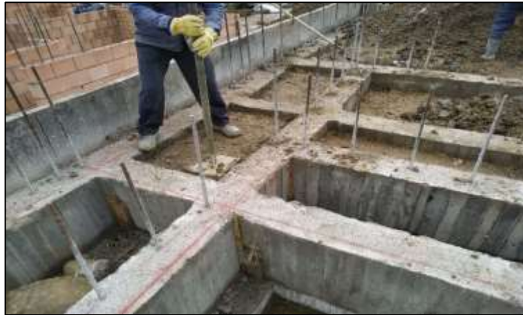
Figura 16 Desencofrado zarpas de cimentación
