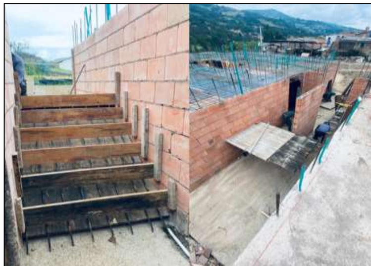
Figura 27 Encofrado de escalones
