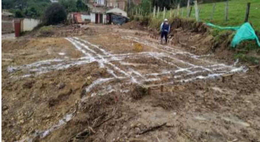
Figura 5 Localización y replanteo de la torre 2.
