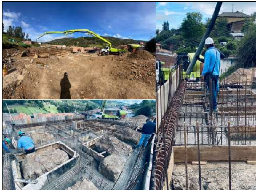
Figura 12 Fundición zarpas de cimentación
