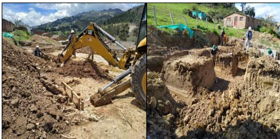
Figura 6 Localización y replanteo de la torre 2.
