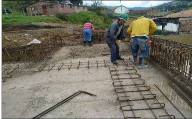
Figura 8 Acero de refuerzo zarpa de cimentación
