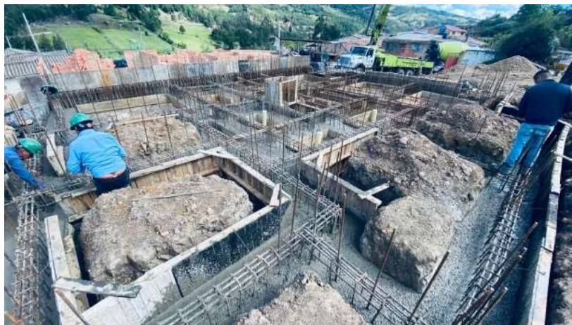
Figura 11 Encofrado de zarpas de cimentación
