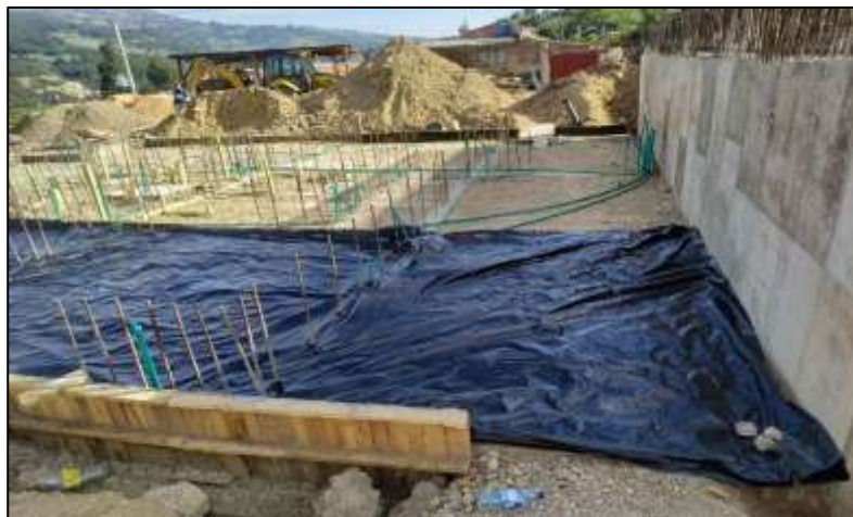
Figura 19 Instalación plástico negro en obra.
