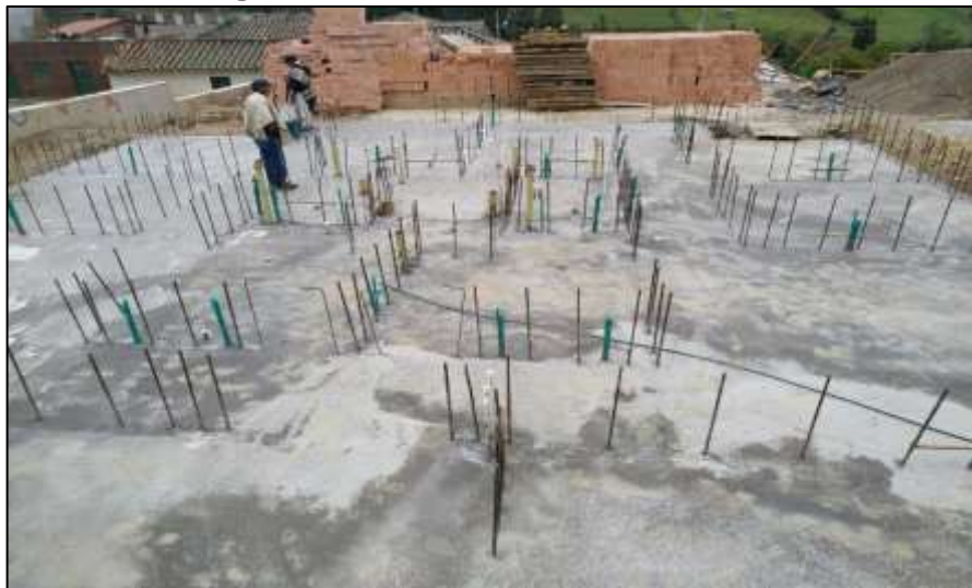
Figura 22 Fundición losa de cimentación
