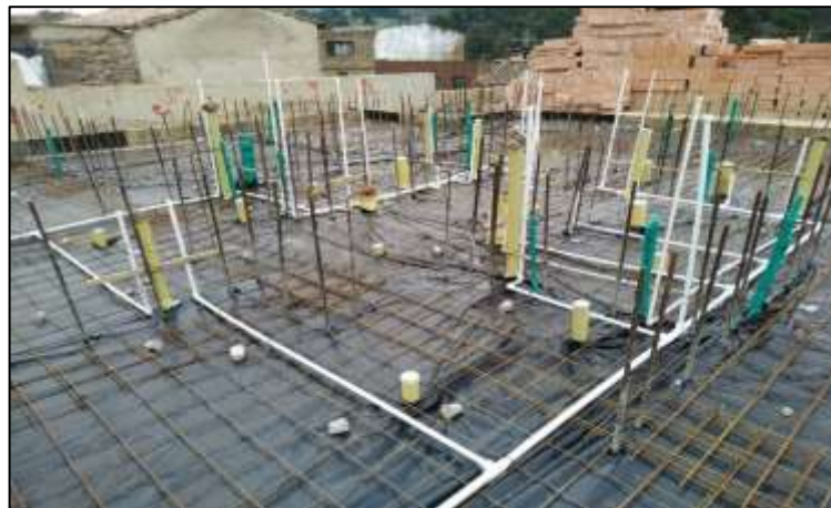
Figura 21 Instalación red hidráulica PVC Y Cpvc
