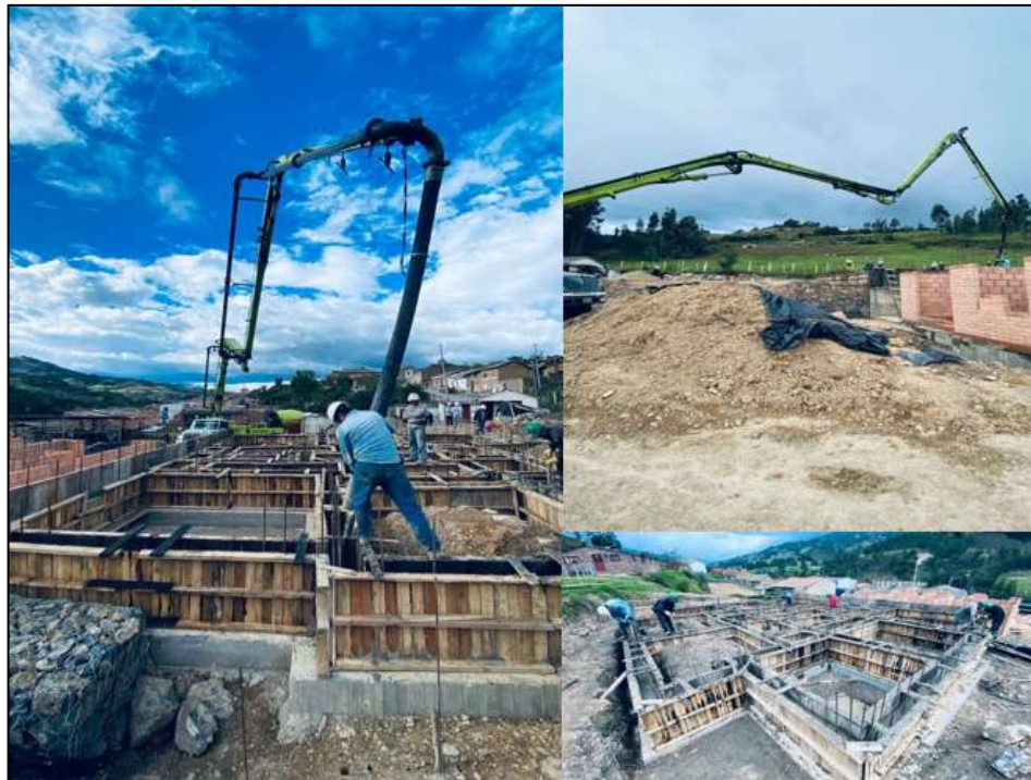
Figura 15 Fundición vigas de cimentación
