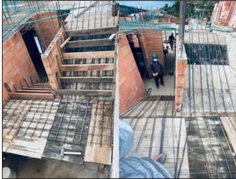
Figura 28 Acero de refuerzo para escalones
