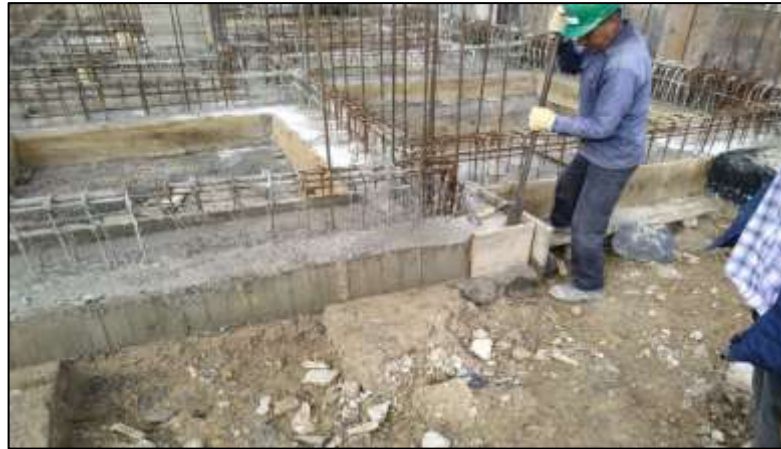
Figura 13 Desencofrado zarpas de cimentación
