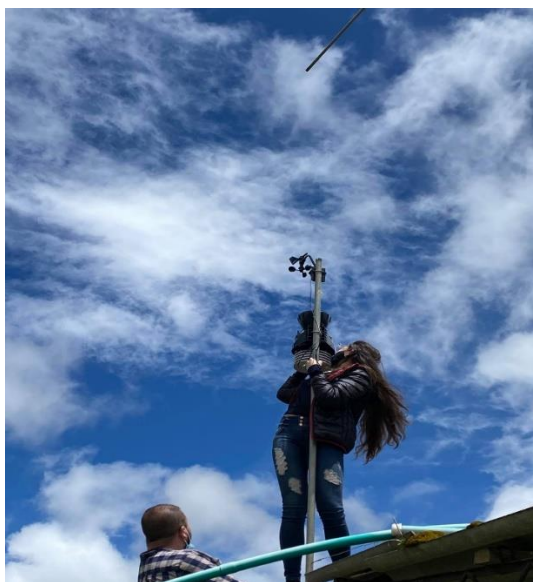
Fotografía 4. Instalación de la estación meteorológica.
