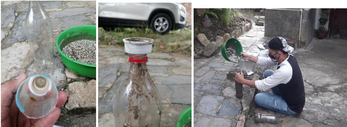
Imagen 17, 18, 19. Proceso de relleno se las botellas PET con de los materiales arena, icopor y cascarilla de. Fuente del autor.
