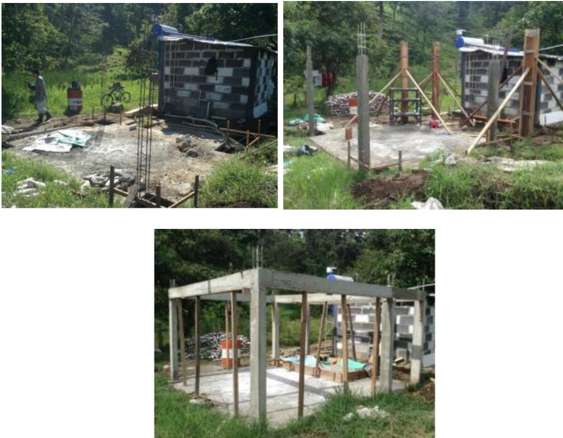
Imagen 26, 27, 28. Estructura de vigas y columnas en concreto. Diseño y construcción de un módulo de vivienda con botellas reciclada. (Aguirre, Rodríguez, 2016). Trabajo de grado. Universidad Tecnológica de Pereira.
