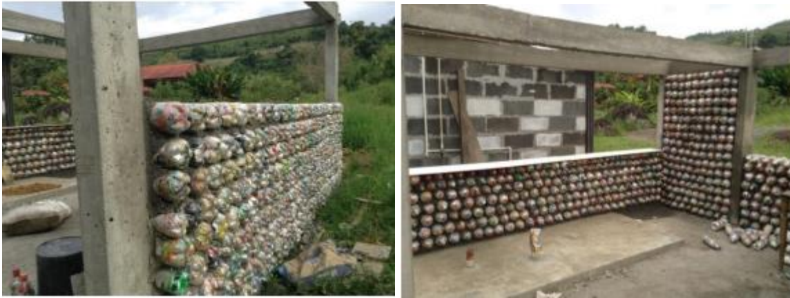
Imagen 30, 31. Construcción de muros. Diseño y construcción de un módulo de vivienda con botellas reciclada. (Aguirre, Rodríguez, 2016). Trabajo de grado. Universidad Tecnológica de Pereira.
