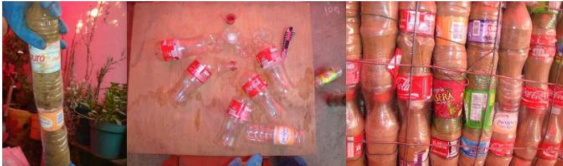
Imagen 5. Unión vertical de botellas (izq), Elementos de refuerzo de unión (cen). Confinamiento vertical dentro de malla de acero (der). El PET como sistema alternativo para la construcción de muros en la vivienda. Tomado de construcción con botellas de plástico (González, 2019)
