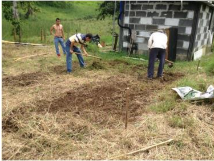
Imagen 21. Preparación del terreno. Diseño y construcción de un módulo de vivienda con botellas reciclada. (Aguirre, Rodríguez, 2016). Trabajo de grado. Universidad Tecnológica de Pereira.
