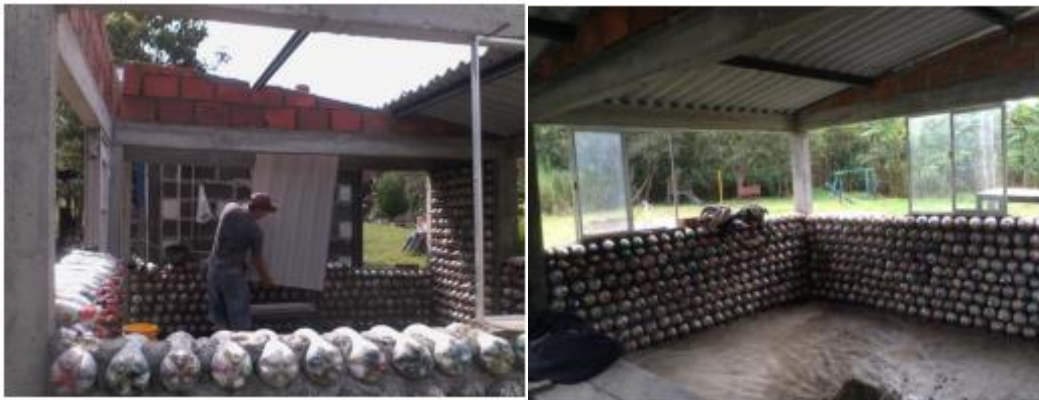
Imagen 32, 33. Bases para el techo. Diseño y construcción de un módulo de vivienda con botellas reciclada. (Aguirre, Rodríguez, 2016). Trabajo de grado. Universidad Tecnológica de Pereira.
