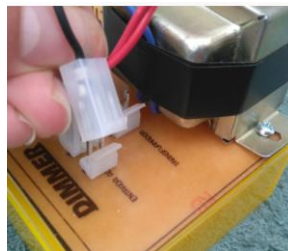
Figura 26 Conexión Dimmer red eléctrica local. Fuente: Autor.
