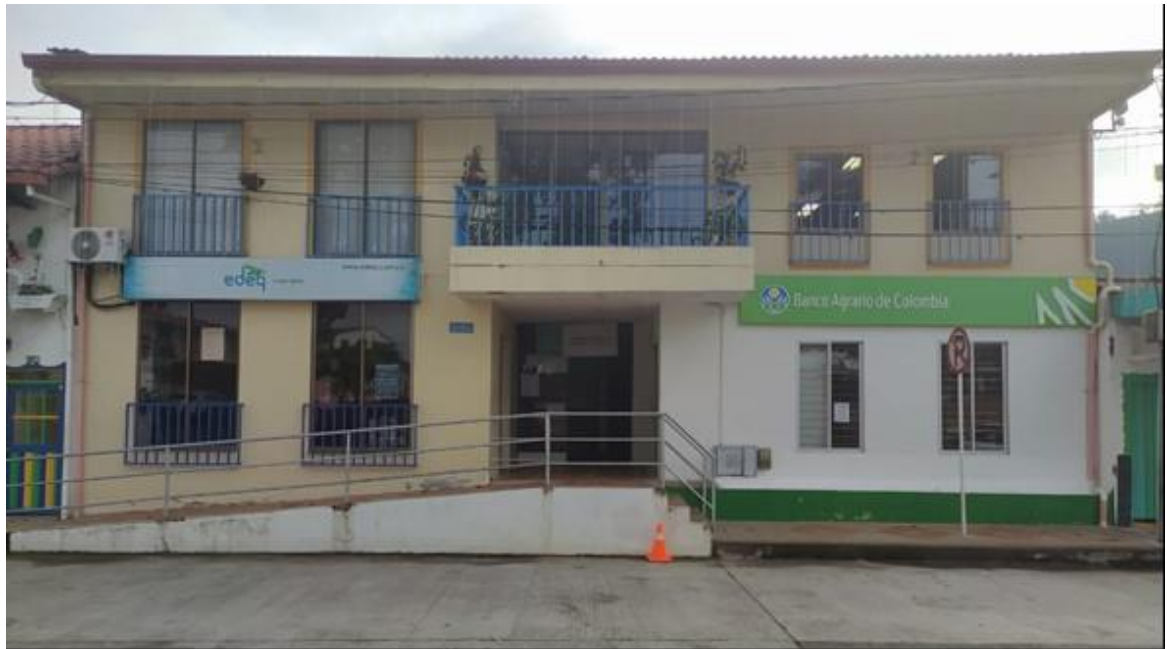
Fotografía 1 Fachada de edificación de estudio (El Autor)
