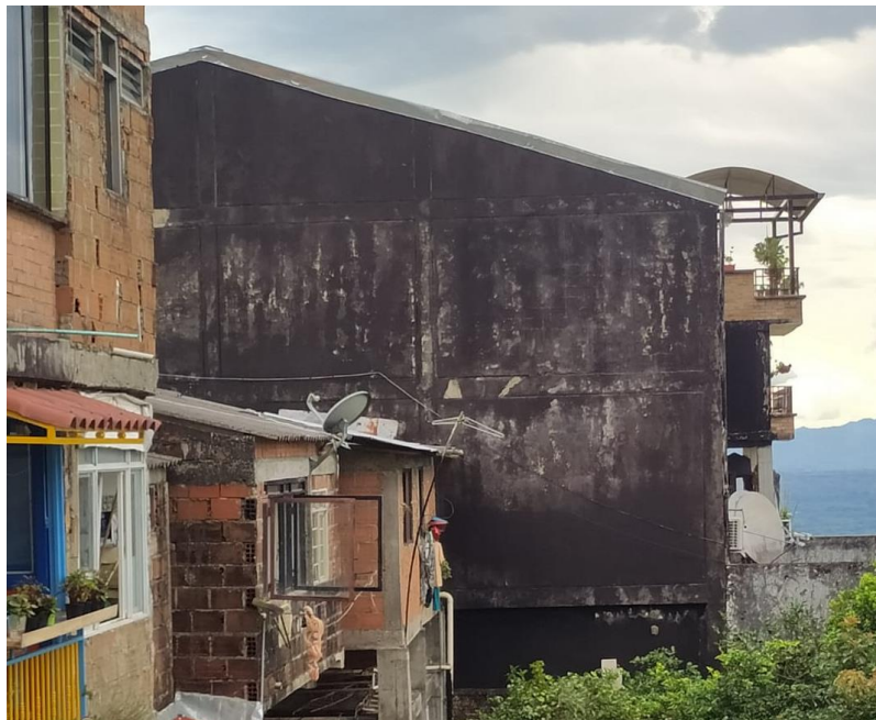
Fotografía 18 Fachada lateral Edificación de estudio (Autor)
