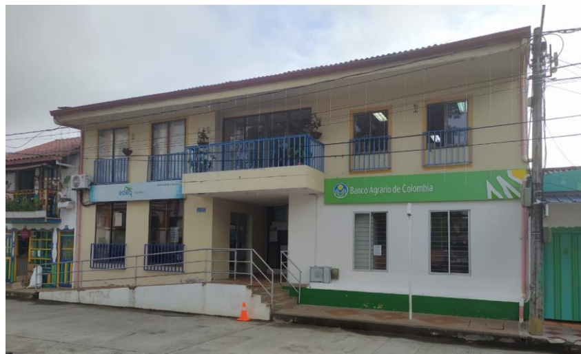
Fotografía 16 Fachada principal - Edificaciones Vecinas (Autor)
