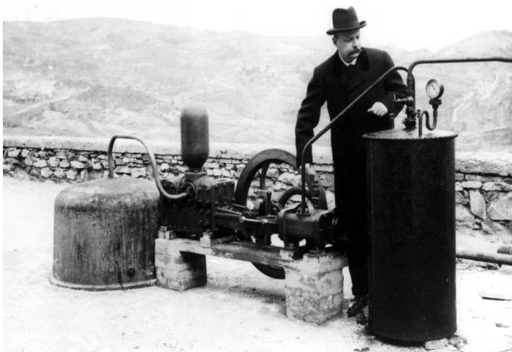
Fotografía 2. Primera planta geotérmica con capacidad de 250 kW en Larderello
