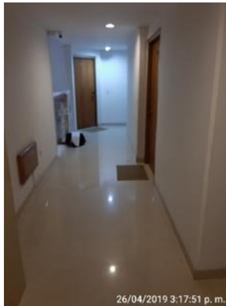
Figura 33. Vista General Estado Actual Zona Común Piso 2. Fuente: Elaboración propia
