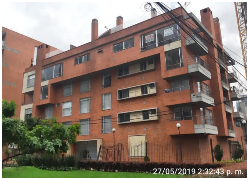
Figura 9. Vista Panorámica Estado Actual Edificio Manglar. Fuente: Elaboración propia
