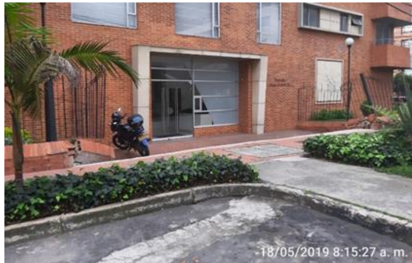
Figura 31. Vista Panorámica Acceso Principal Peatonal. Fuente: Elaboración propia
