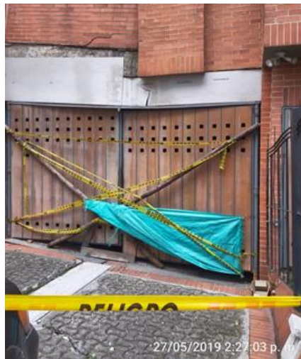
Figura 26. Vista Frontal Puerta de Acceso a Parqueadero. Fuente: Elaboración propia
