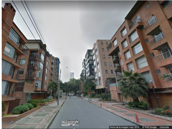
Figura 19. Vista General Estado Actual de Zona de Vivienda. Fuente: Elaboración propia
