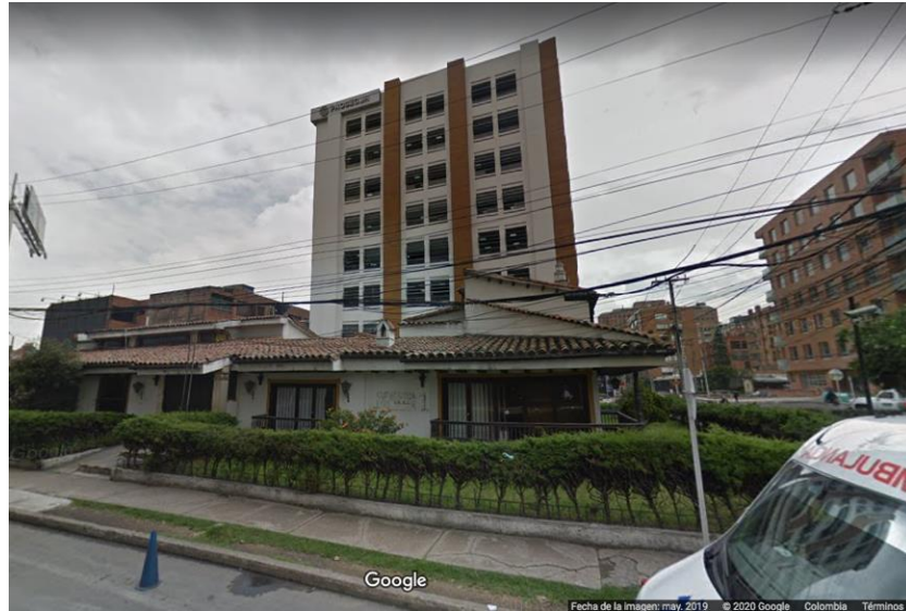
Figura 21. Vista General Edificación Curaduría. Fuente: Google Maps.
