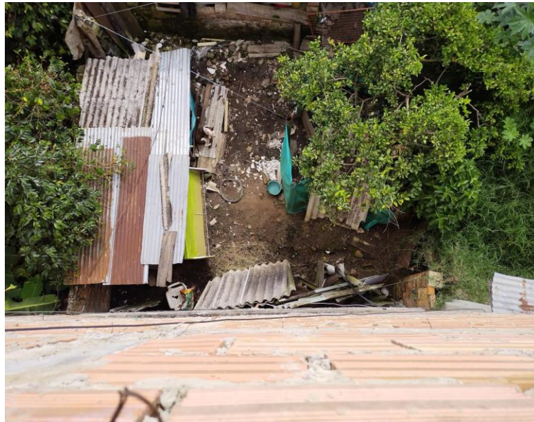
Figura 19 Vista aérea de la zona afectada
