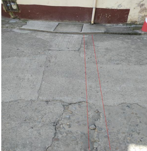
Figura 18 Condiciones de la calle 5 #9 lote 1
