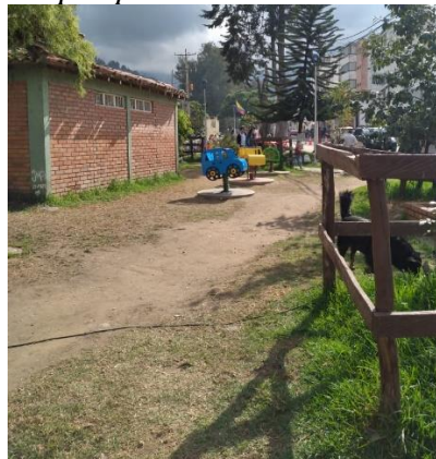
Figura 57. Estado Zonas verdes del parque
