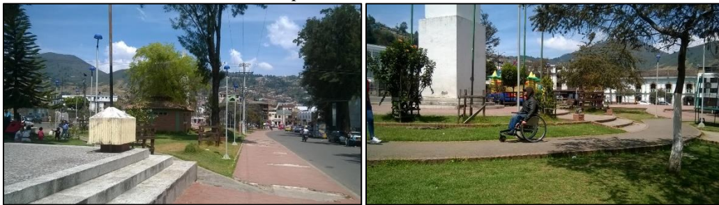
Figura 7. Estado actual de los senderos peatonales
