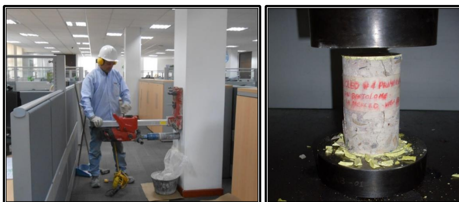
Figura 15. Extracción y prueba de núcleos de concreto. Imágenes de Referencia. Fuente Propia
