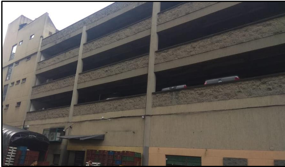
Figura 6. Fachada oriental del edificio de parqueaderos de Corabastos. Fuente Propia
