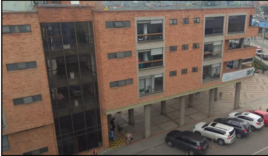
Figura 5. Esquina suroriental del edificio administrativo de Corabastos. Fuente Propia
