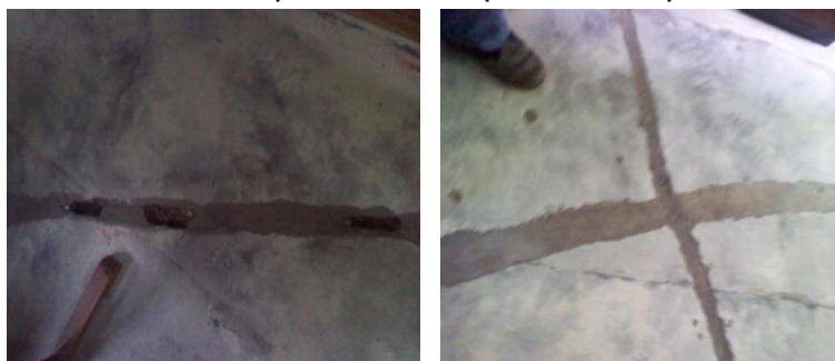
Figura 6. Acercamiento al piso de la Inspección de policía en San Alberto, Cesar.
