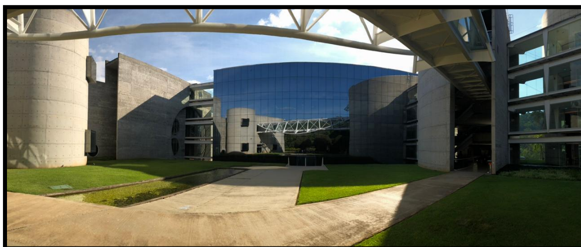
Edificio administrativo con señalización para aves que habitan en la zona
