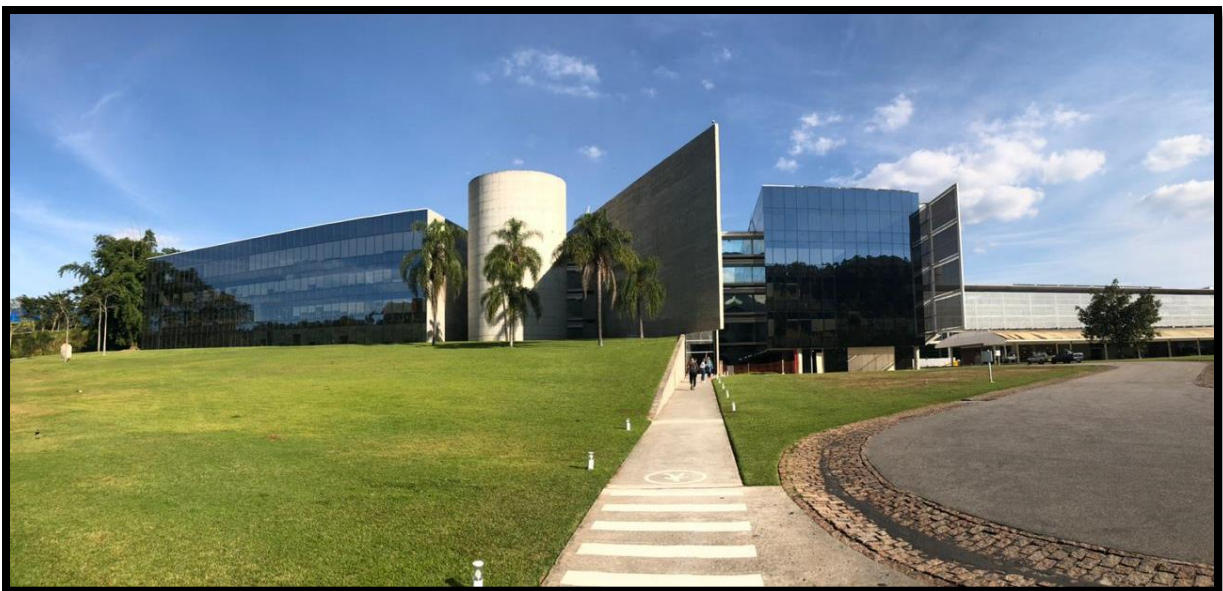
Panorámica de la planta
