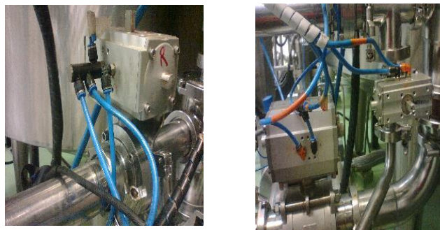
Figura 24. Instalación de sistema Pig Pusher
