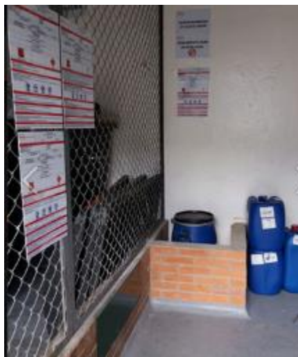
Figura 36. Dique de Almacenamiento para el almacenamiento de aceite usado. Señalización de áreas.
