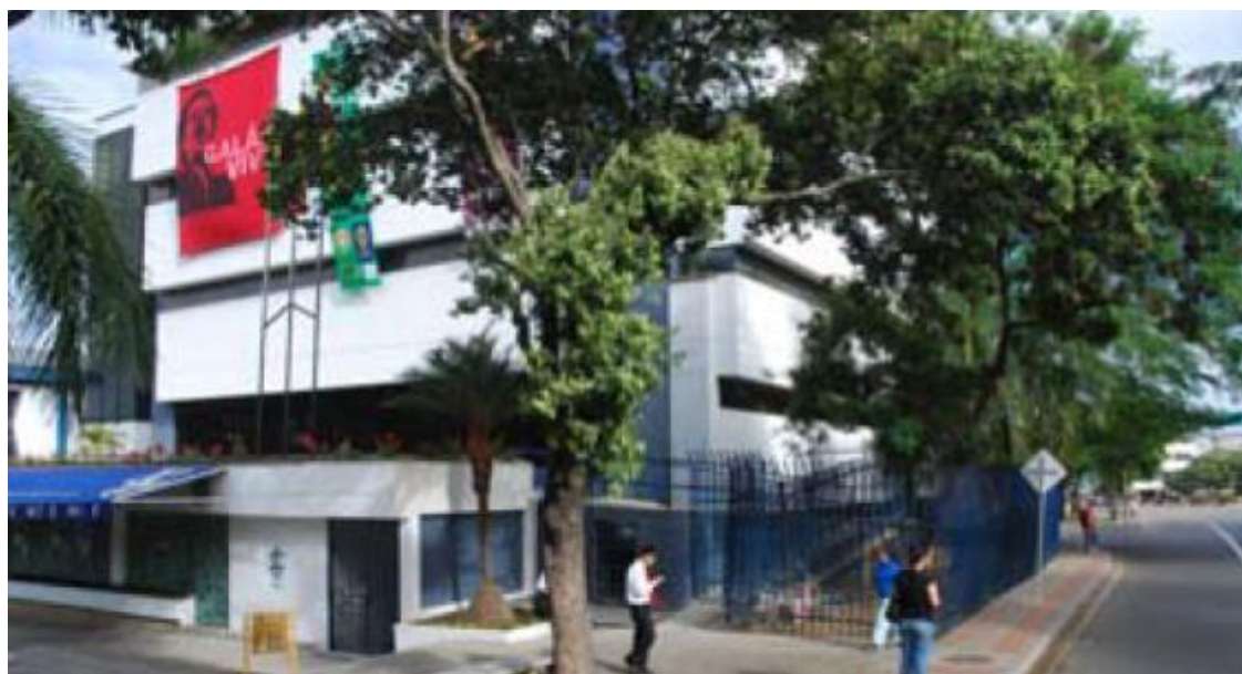
Figura 5. Registro fotográfico de fachada
