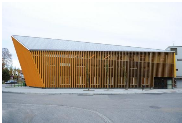
Figura 33. Fachada compuesta con elementos verticales Biblioteca Pública en Vennesla
